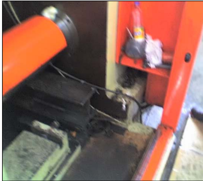
FIGURA 3.14. PARTE INTERNA CON PUERTA ABIERTA
