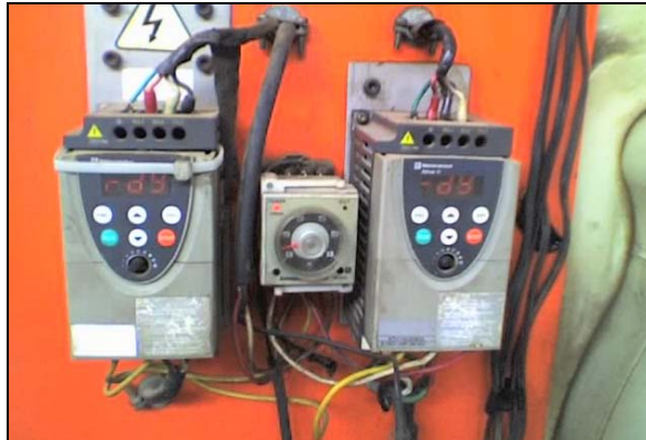
FIGURA 3.3. PARTE ELÉCTRICA CON PUENTES
