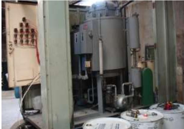
**FIGURA 3.3 EQUIPO FILTRADOR DE ACEITE PARA LOS TRANSFORMADORES**
