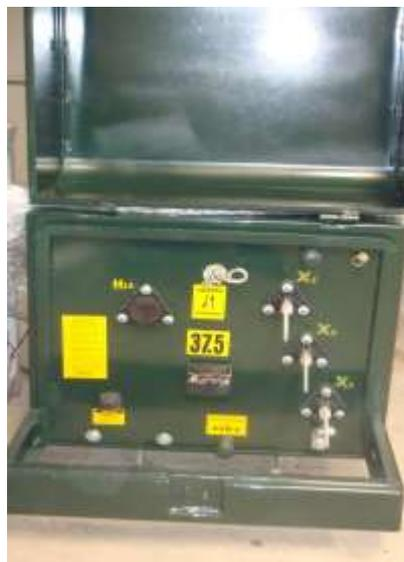
**FIGURA 1.1 TRANSFORMADOR TIPO PAD-MOUNTED DE PRODUCCIÓN ACTUAL**
