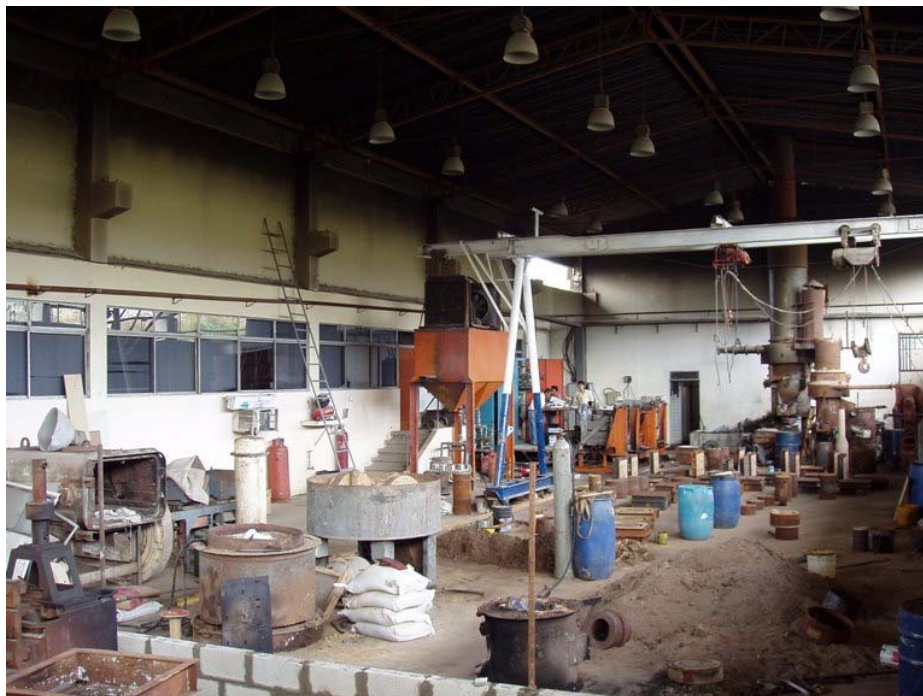
FIGURA 2.11 VISTA GENERAL DE LA NAVE DE PRODUCCIÓN
