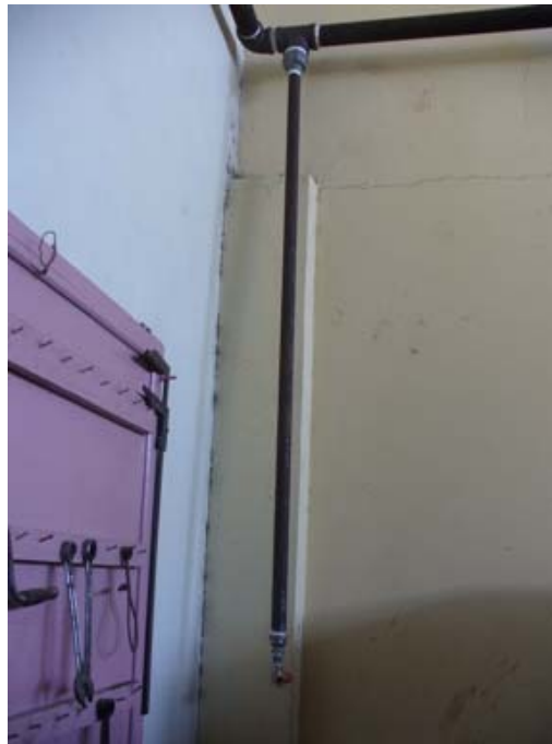
FIGURA 2.14 MONTAJE DE PURGAS DE CONDENSADO
