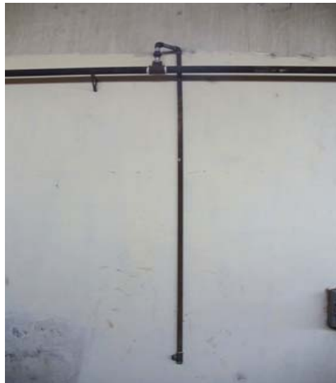
FIGURA 2.13 MONTAJE DE BAJANTE DE TOMA DE AIRE
