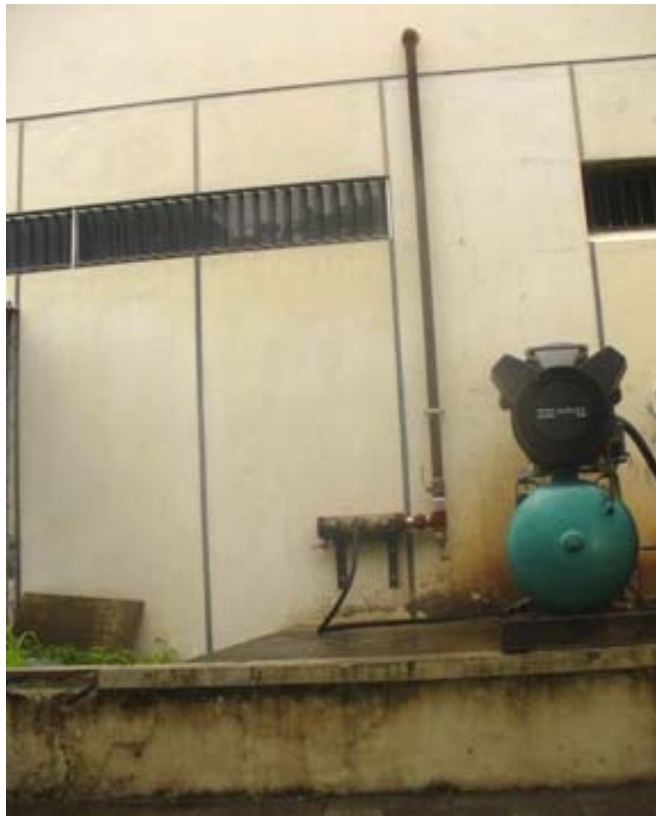
FIGURA 2.3 MONTAJE DE COMPRESOR
