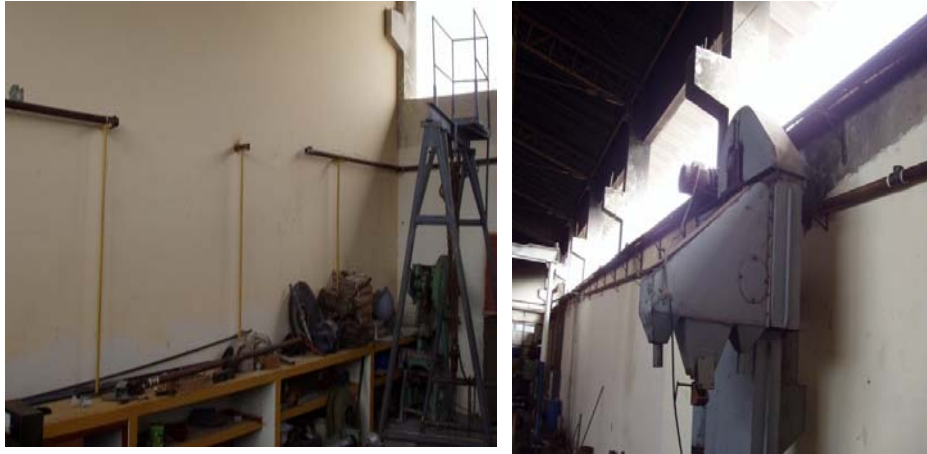
FIGURA 2.10 MONTAJE DE TUBERÍAS
