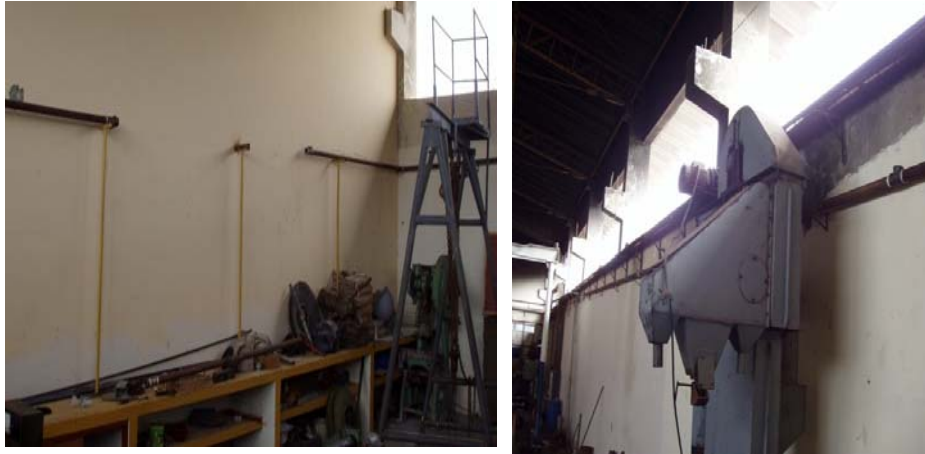
FIGURA 2.10 MONTAJE DE TUBERÍAS
