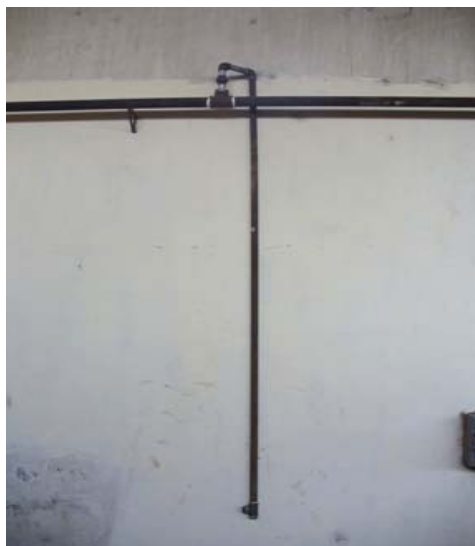
FIGURA 2.13 MONTAJE DE BAJANTE DE TOMA DE AIRE
