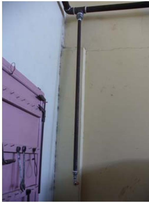
FIGURA 2.14 MONTAJE DE PURGAS DE CONDENSADO
