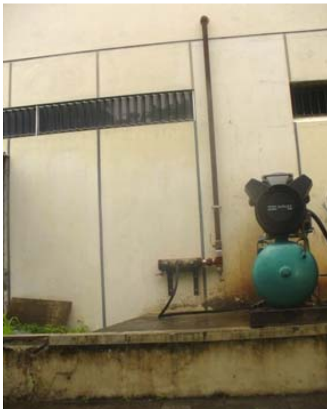
FIGURA 2.3 MONTAJE DE COMPRESOR
