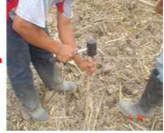
Colocacion de estacas
