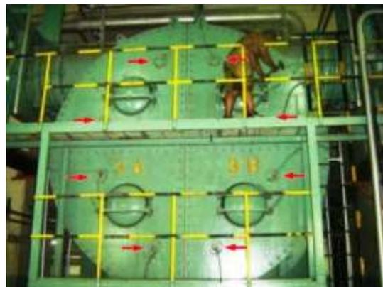
**FIGURA 1.7 DISPOSICIÓN DE LOS ÁNODOS EN EL
