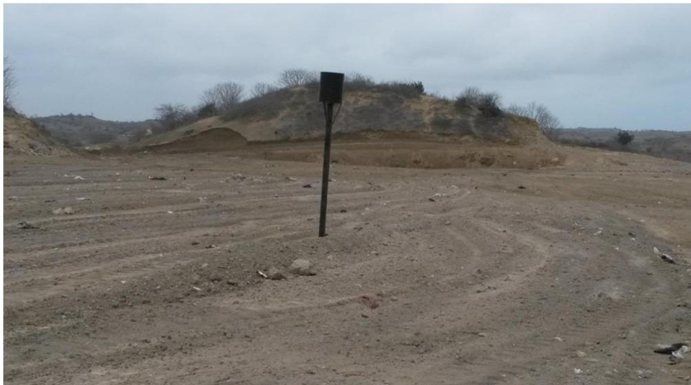
Fotografía 14 Salida de gases del relleno sanitario en fase de cierre.
