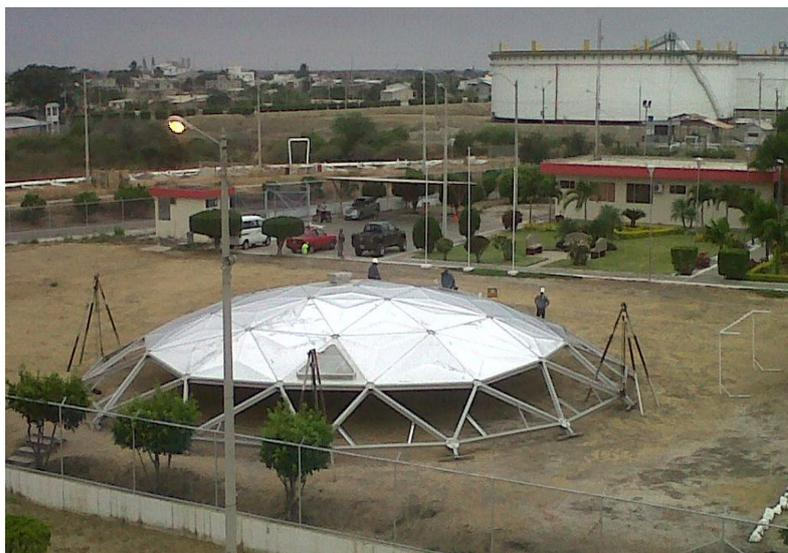
*Foto.17 Instalación de los paneles del Domo.<sup>49</sup>*
