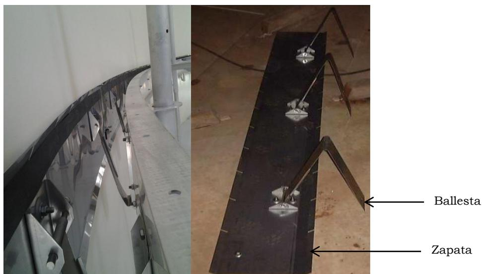
*Foto 25 Ubicación de Zapata y Ballesta en el Aro Perimetral.<sup>59</sup>*
