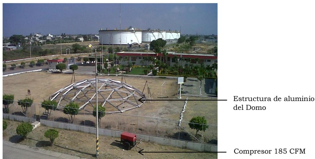
*Foto 16 Estructura del Domo ubicado en las canchas de la Estación de Almacenamiento y Transporte.<sup>47</sup>*
