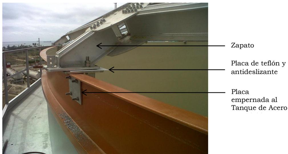
*Foto.19 Instalación de los zapatos de soporte.<sup>51</sup>*
