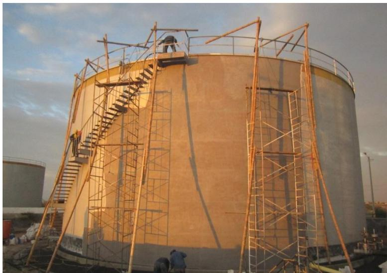
*Foto 7 Sandblasting del Tk-02-Gasolina<sup>35</sup>*
