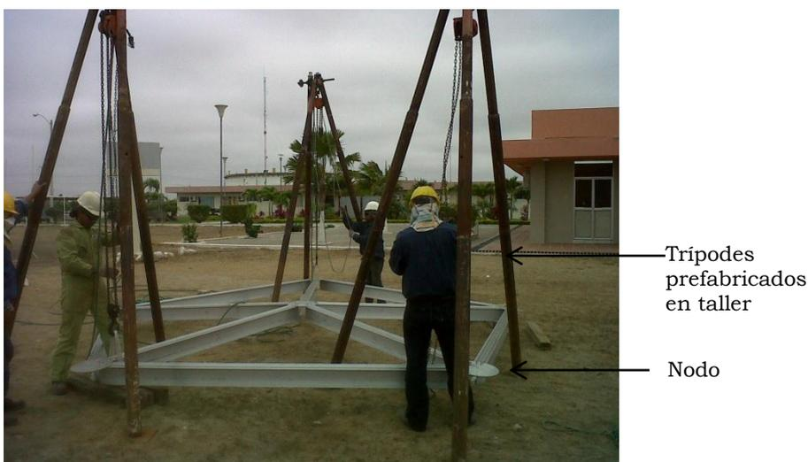
Foto 15. Inicio del armado del Domo.<sup>46</sup>
