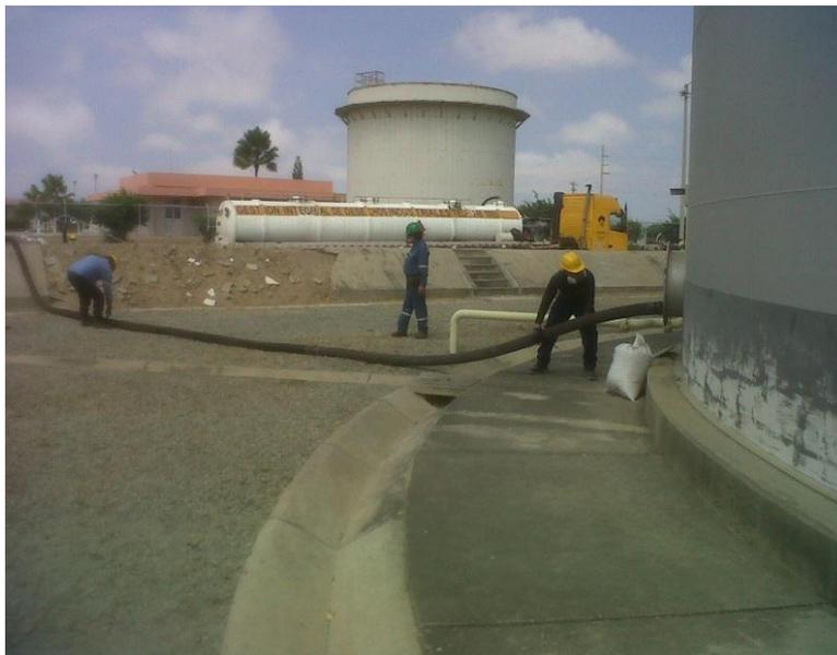
*Foto 4 Evacuación de lodos en fondo del Tk-02-Gasolina<sup>27</sup>.*
