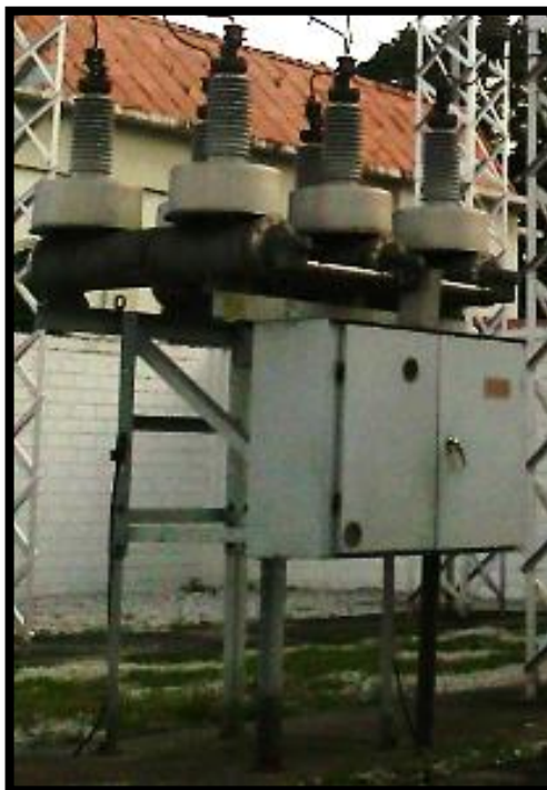
Figura 2.6: Interruptor en gas SF6 de 69 kV.
