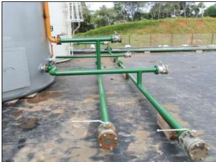
**FIGURA 2. 7: Manifold de conexión de los tanques de almacenamiento**
