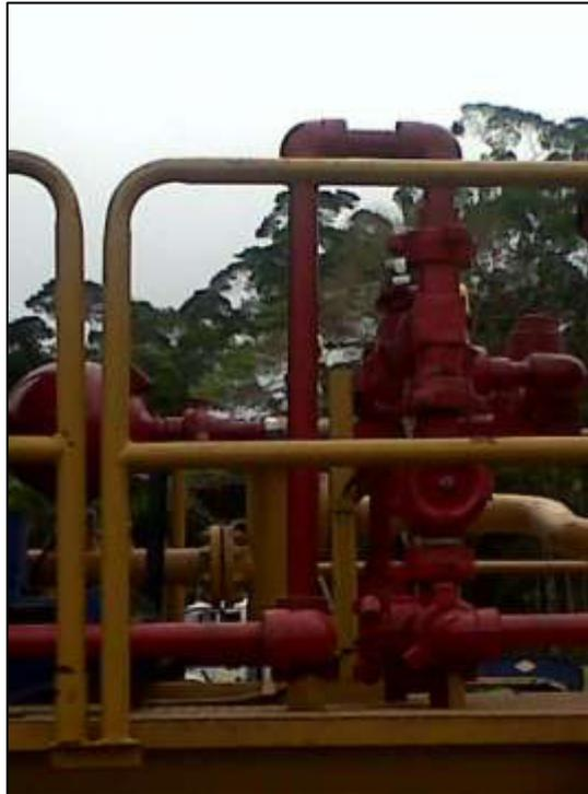
**FIGURA 2.12: Manifold Inyección/Producción**
