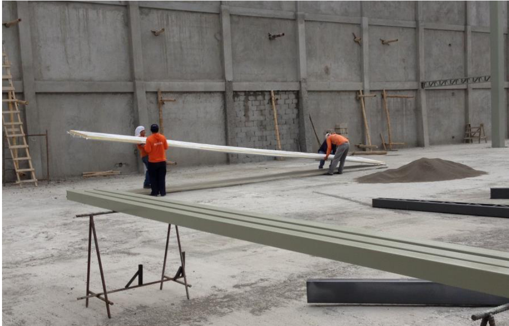
Fig. 6.3.- Personal realizando movimiento de los paneles (Autor: Alfredo Bozano, José Vera)
