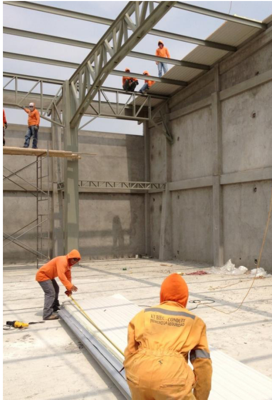
Fig. 6.4 Selección de paneles según su longitud para subida a estructura. (Autor: Alfredo Bozano, José Vera)
