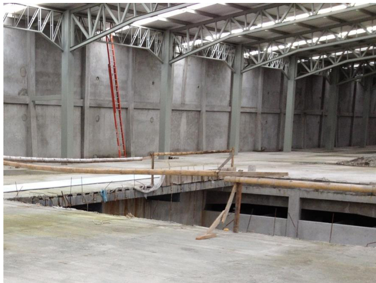
Fig. 6.2.-Escalera telescópica de acceso a la cubierta (Autor: Alfredo Bozano, José Vera)
