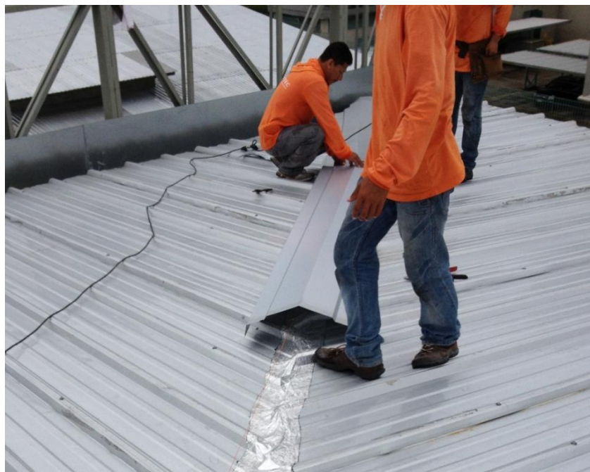
Fig. 6.7.- Instalación de remate tipo cumbrero. (Autor: Alfredo Bozano, José Vera)
