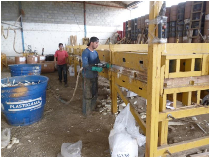
Fig. 3.7.- Inyectado de paneles (Autor: Alfredo Bozano, José Vera)
