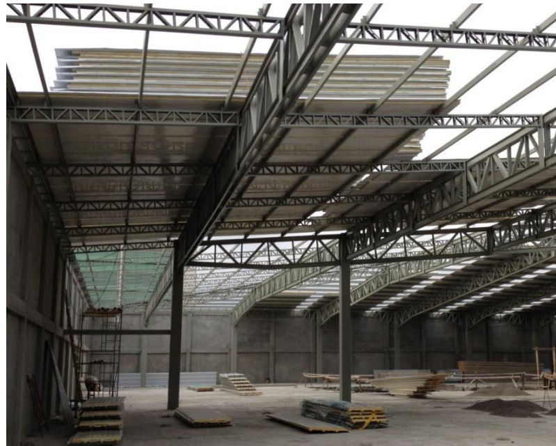
Fig. 6.6.- Acumulación de paneles sobre cubierta. (Autor: Alfredo Bozano, José Vera)
