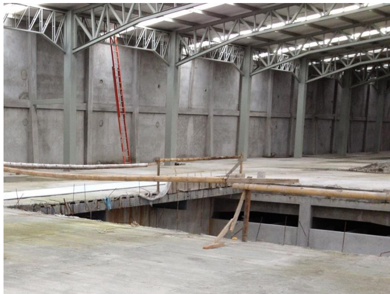
Fig. 6.2.-Escalera telescópica de acceso a la cubierta (Autor: Alfredo Bozano, José Vera)
