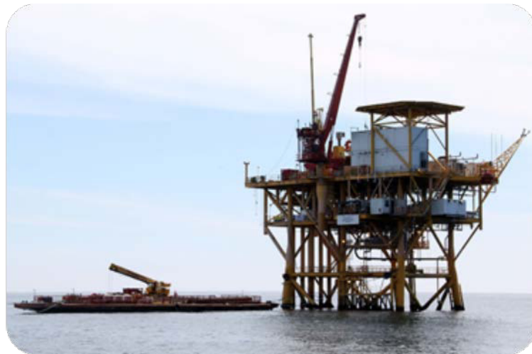
Fig. 1.- Plataforma de Gas natural en Machala
