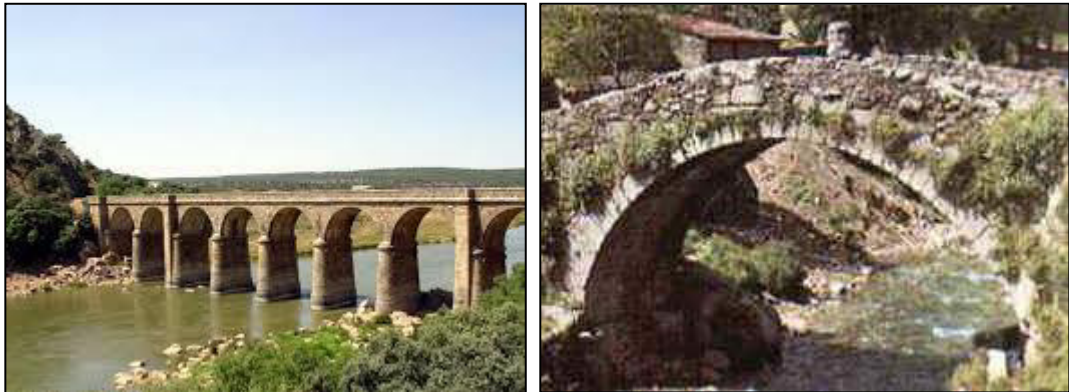
Figura 3.1 Puentes de Mampostería (Tomado de ConocerZamora)
