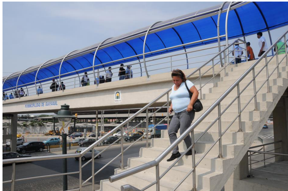
Figura 3.6 Puente peatonal, ubicado en el Terminal Terrestre de Guayaquil (Tomada de Metroecuador, 2011)
