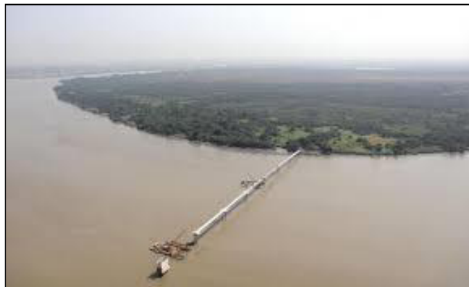
Figura 3.3 Puente sobre Rio Guayas (Santay) ((Tomada por Douglas Armijos))
