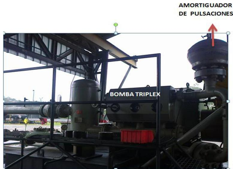
**FIGURA 2. 7: Bomba triplex y amortiguador de pulsaciones**
