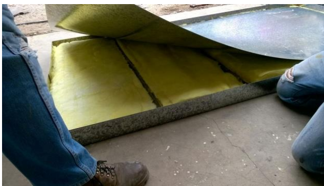
FIGURA 2.7. Aislante Debajo de la Placa Colectora.
