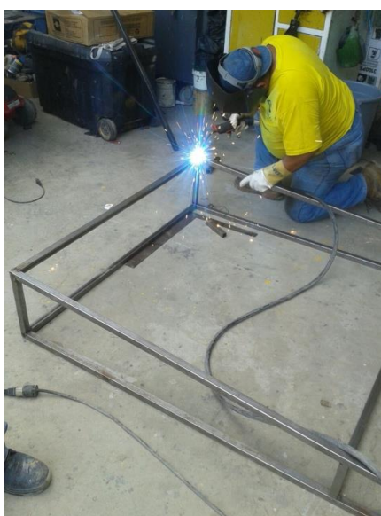
FIGURA 2.10. Construcción del Soporte del Calentador.
