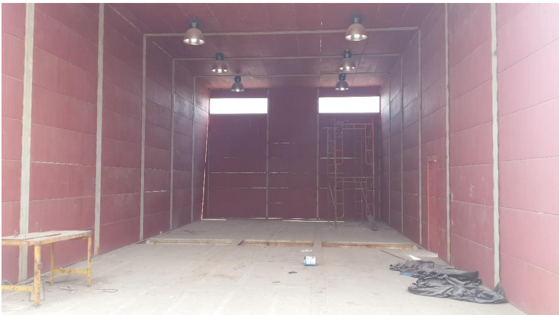
Estructura del cuarto de granallado – Interior
