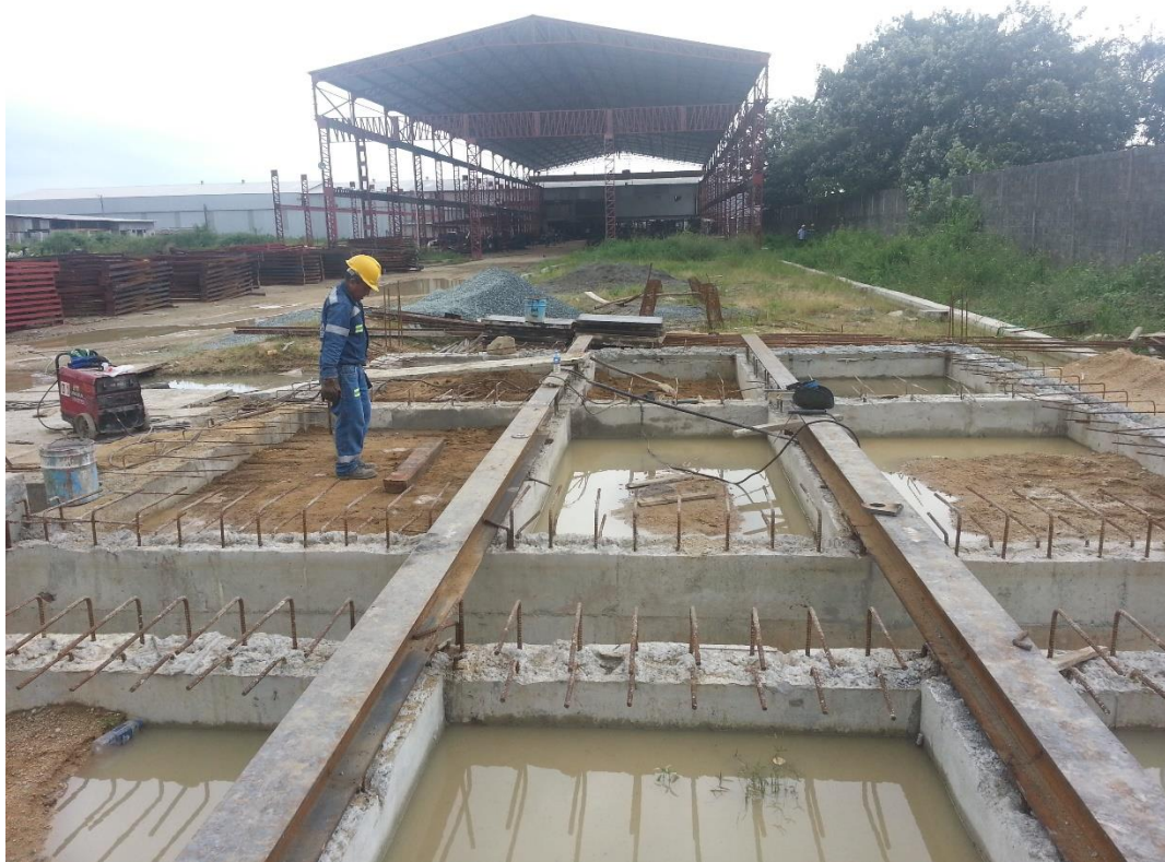
Conformación de losa
