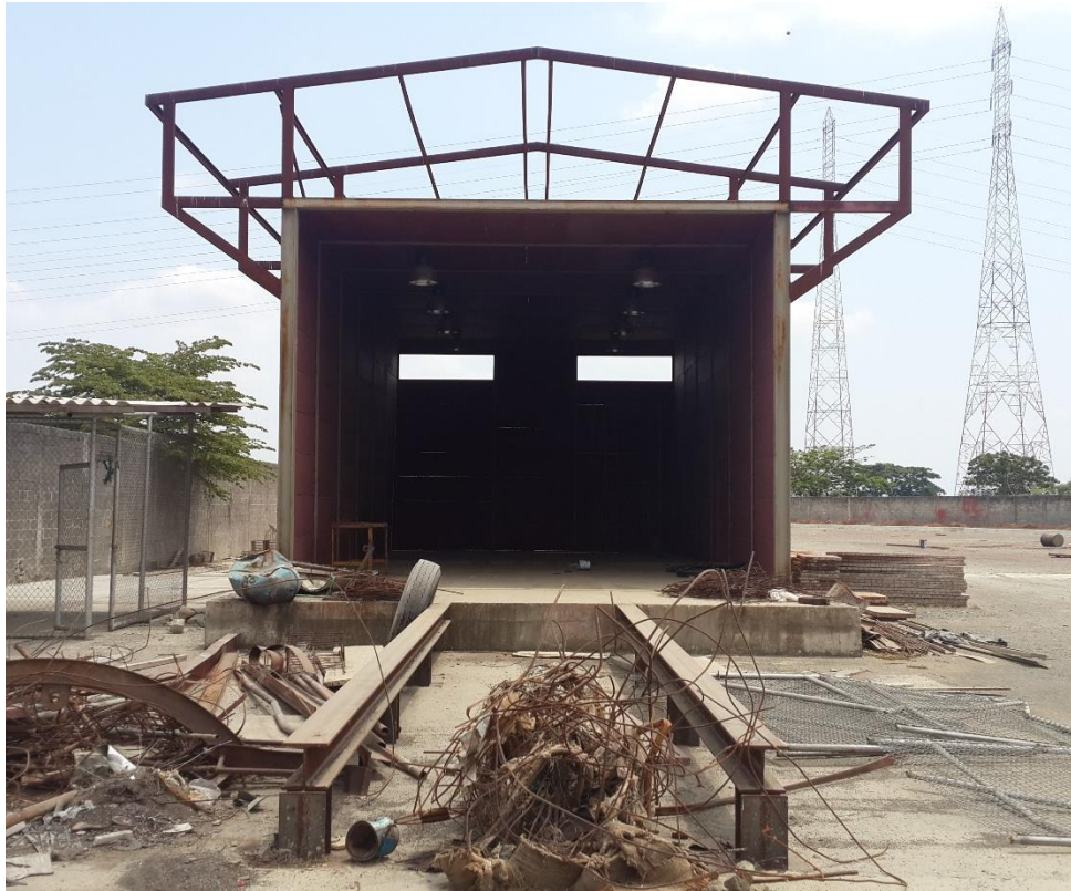
Estructura del cuarto de granallado – Vista frontal
