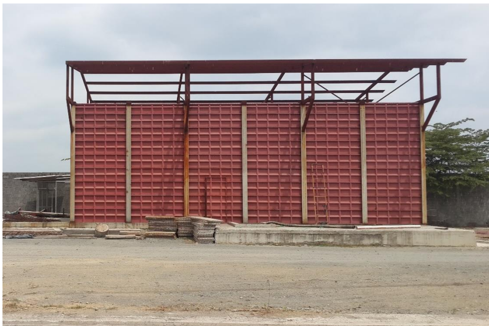
Estructura del cuarto de granallado – Vista lateral
