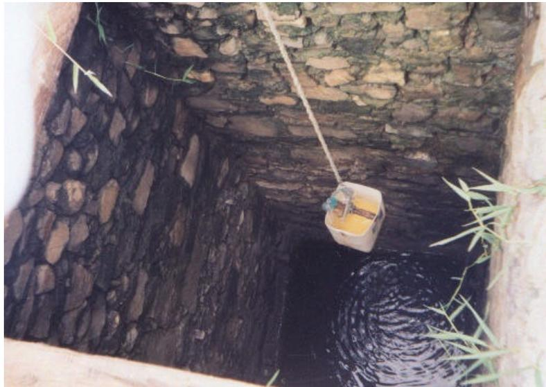
Fig. 5.11 Vista de la boca del pozo de captación de agua subterránea en Saya. Obsérvese lo amarillento de esta agua indicando algún tipo de contaminación
