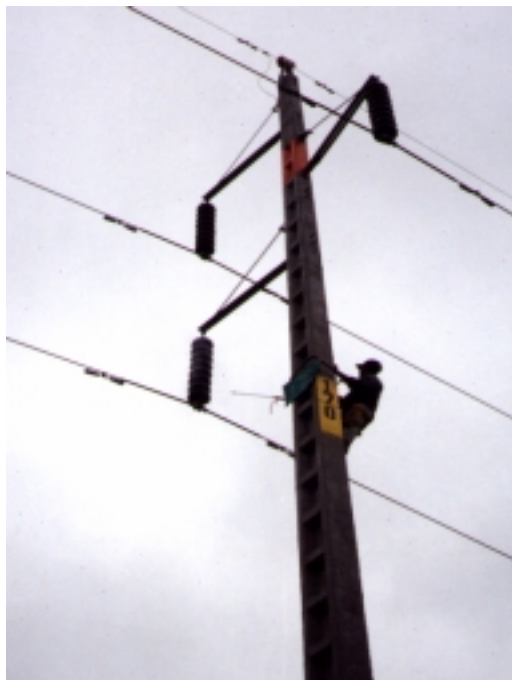
Figura 11.7 Limpieza de aisladores
