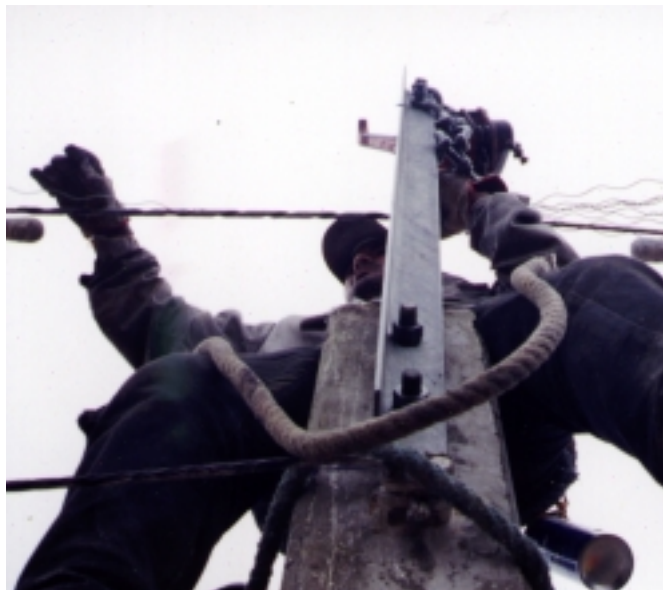
Figura 11.10 Instalación del Blindaje en el H/G
