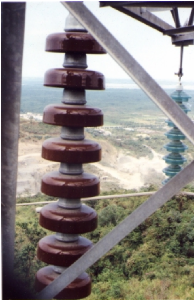
Figura 6.1 Cadena de aisladores Tipo Antifog
