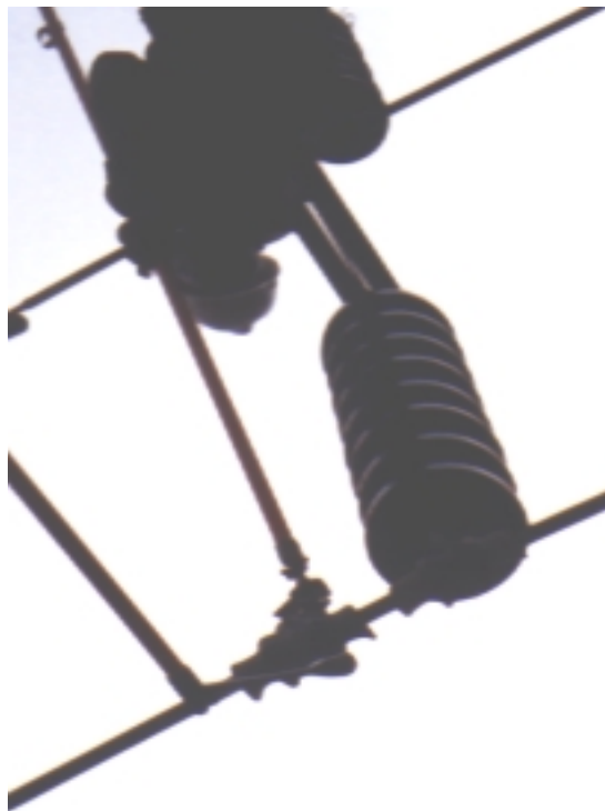
Figura 11.18 Apretando La Grapa con el conductor
