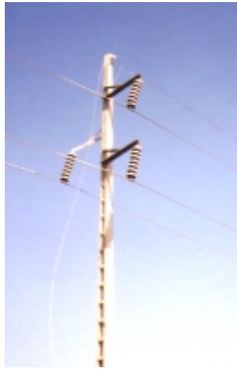
Figura 12.1 H/G Afectado por la Contaminación por Salinidad En la línea de Emepe (Posorja)
