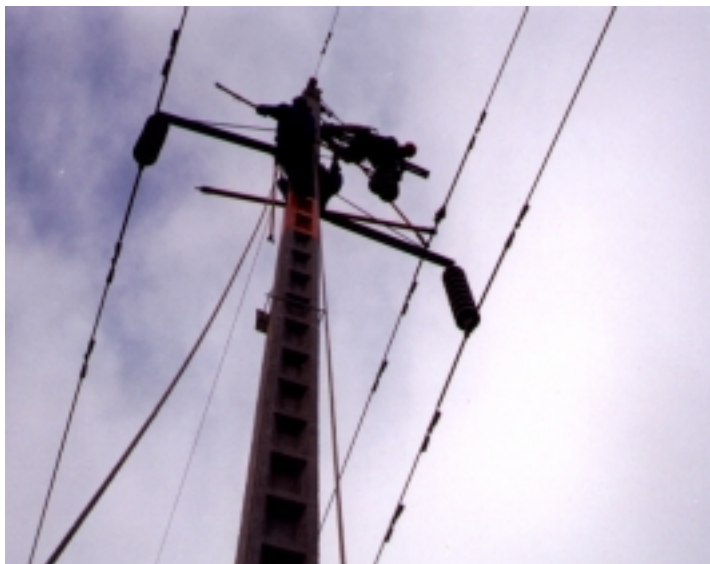
Figura 11.4 Procedimiento para bajar una cadena de aisladores de suspensión, en Línea Energizada.
