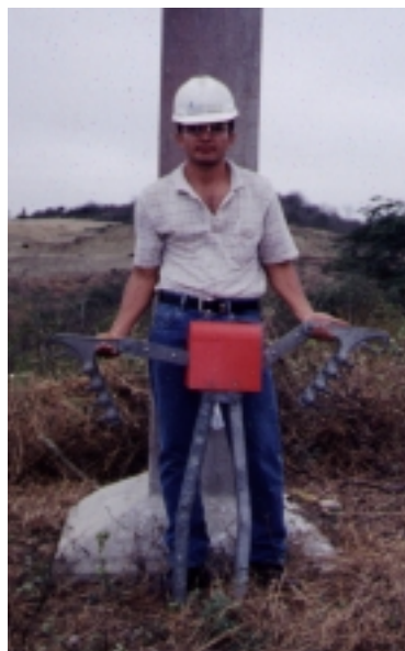
Figura 11.11 Extensión para poste tipo retención
