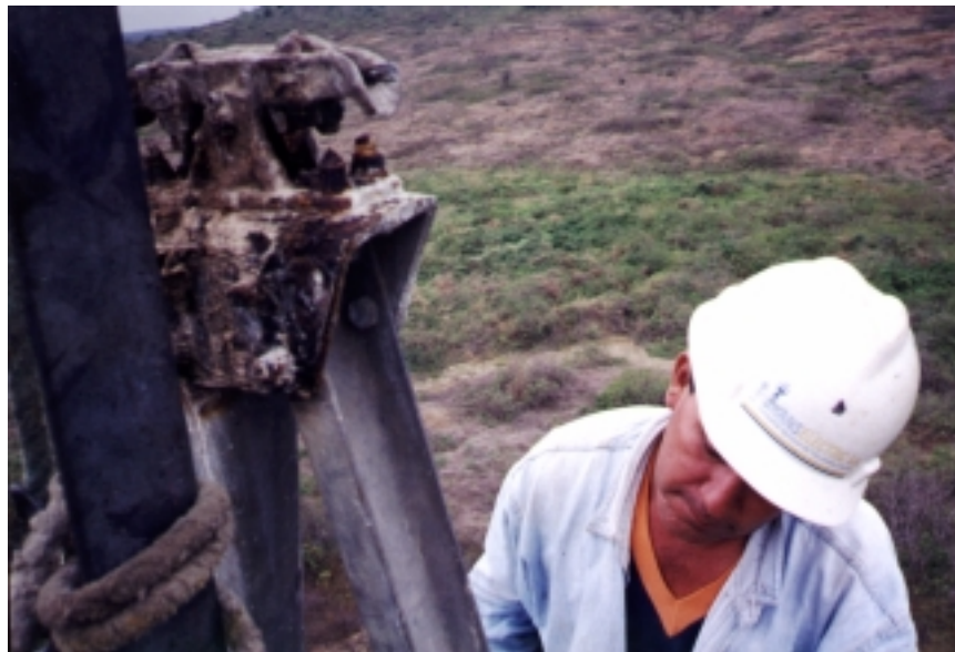
Figura 11.8 Extensión Metálica para poste afectado por la corrosión.
