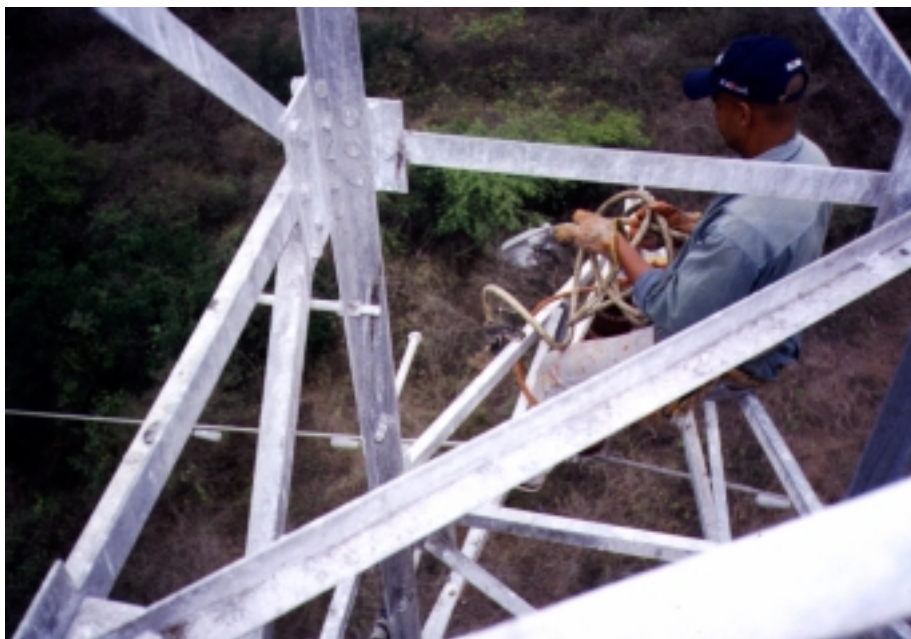
Figura 11.6 Colocación de Tierras Locales
