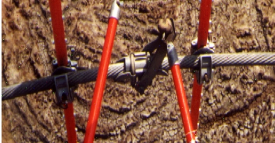
Fig. 2.7 Corrosión en La rotula Corta
