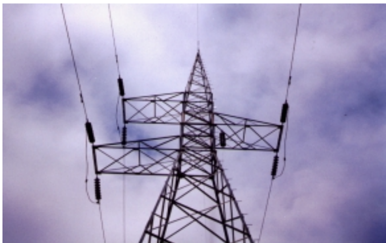
Figura 11. 13 Ubicación de la cadena de aisladores de suspensión
