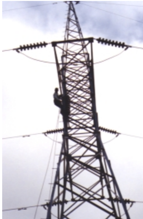
Figura 11.21 Ubicación de la Cadena de Aisladores
