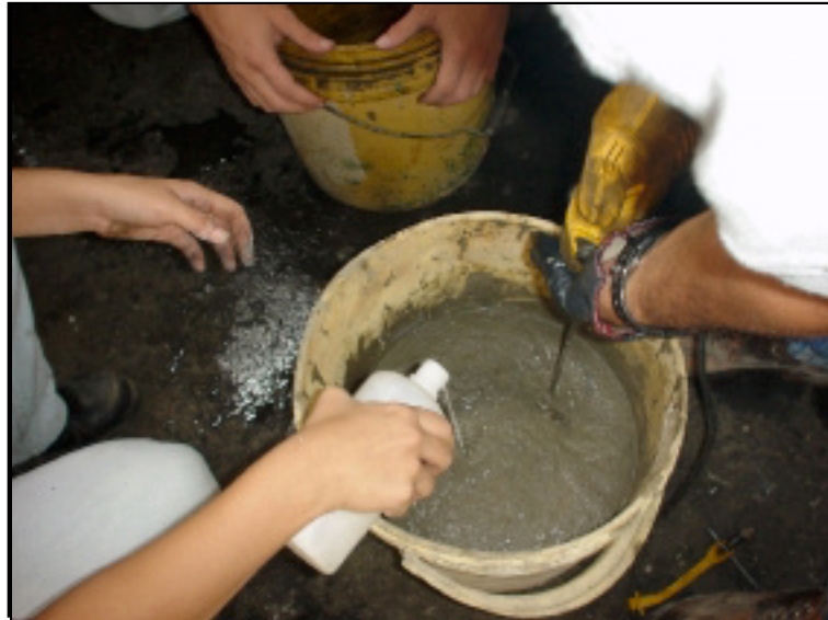
FIGURA. 2 MEZCLA CON TALADRO
