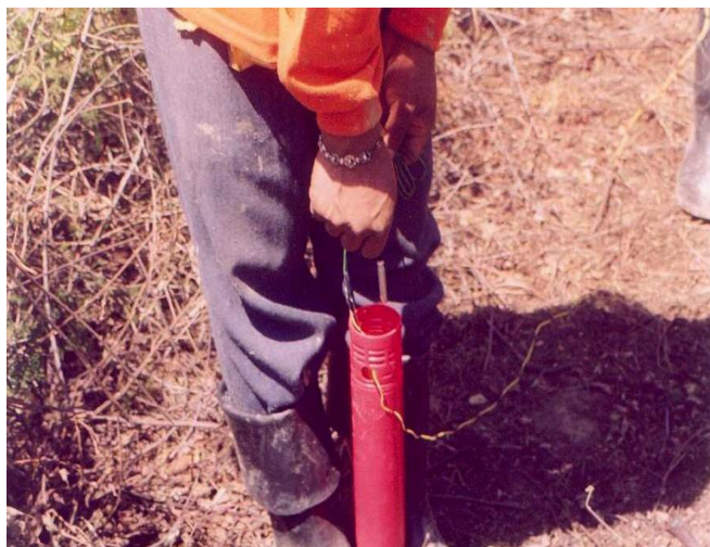
Figura 4.7.- Explosivo con fulminante eléctrico.
