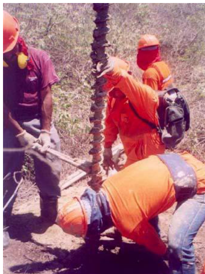
Figura 4.2.- Perforación con espirales en terrenos fangosos.
