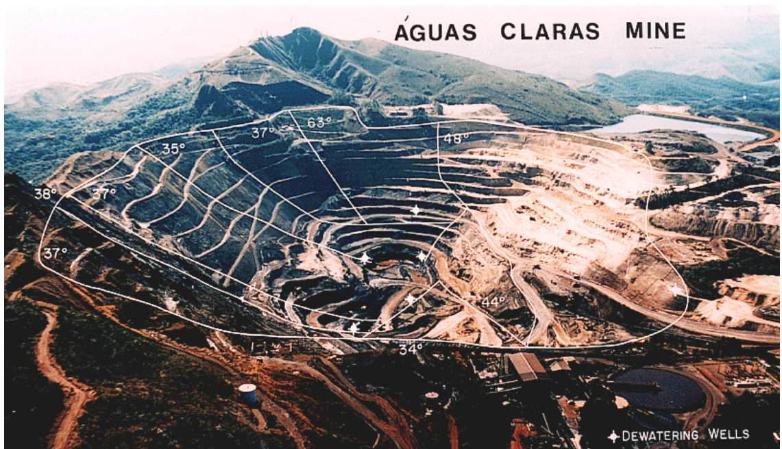
Foto 2.4 – Mina de Aguas Claras – Angulos Generales de los taludes
