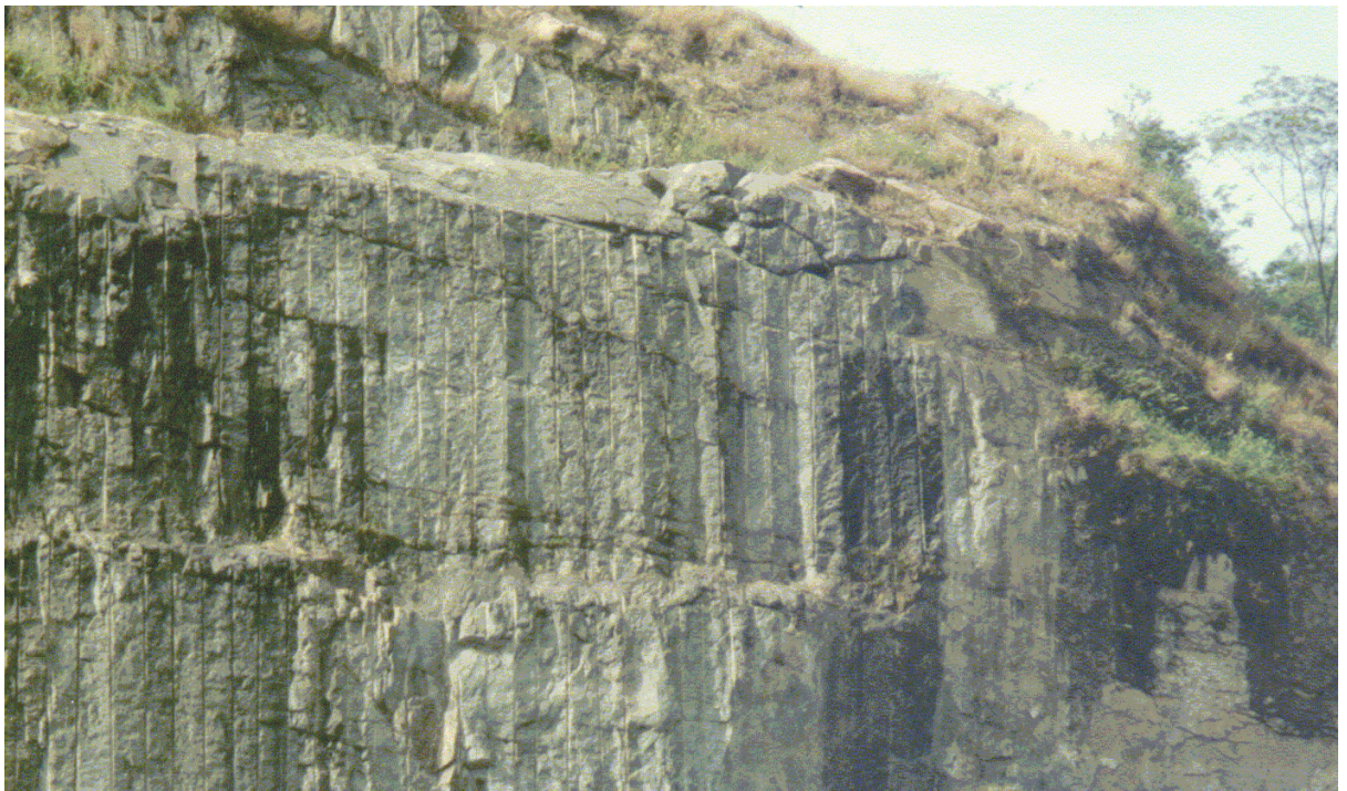
Foto 3.1 – Acabado de un Talud
