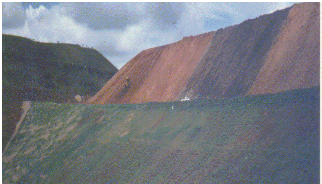
Foto 4.1 - Preparación del Talud con tractor
