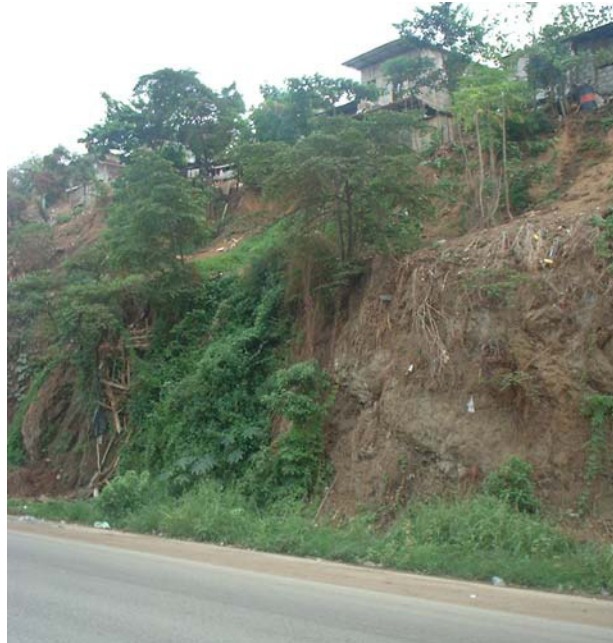
Foto 2.6. Cerro Jordán, talud con pendiente > 60%, colindante con la vía Perimetral
