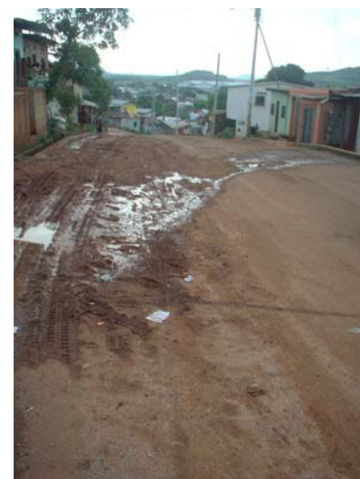
Fotos 3.7, 3.8 y 3.9 Bastión Popular, Bloque 10. El material arrastrado por el agua, pendiente abajo es evidente, toda la calle asfaltada ha sido cubierta de un material café rojizo, color característico de los suelos de la formación Cayo. Este material es parte del suelo que se ha desprendido de la colina.
