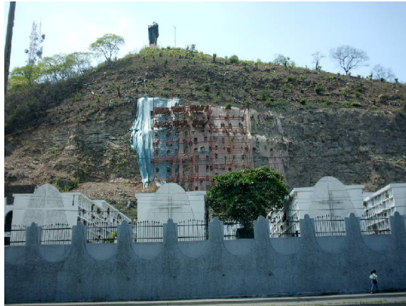
Foto 3.18 Trabajos de estabilización al pie del monumento del Corazón de Jesús del lado del cementerio, marzo 2005. Sitio cantera, de donde se explotó material pétreo para relleno.
