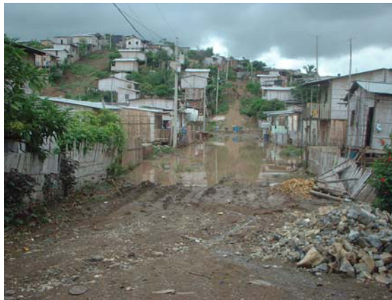
Foto 3.10 Guerrero del Fortín, Se observa acumulación de agua por falta de alcantarillado pluvial, además de material lodoso o fangoso arrastrado por el agua.
