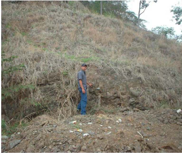
Foto 2.19 Deslizamiento de material coluvio-aluvial
