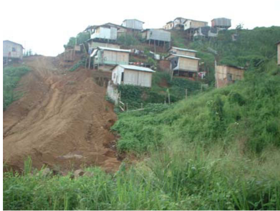
Foto3.12 Balerio Estacio. Construcción de viviendas sobre pendiente muy pronunciada.
