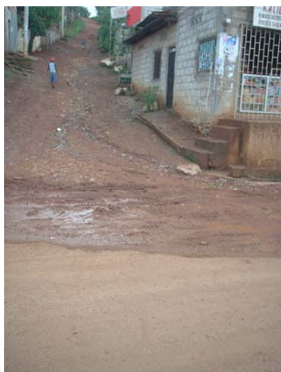
Fotos 3.7, 3.8 y 3.9 Bastión Popular, Bloque 10. El material arrastrado por el agua, pendiente abajo es evidente, toda la calle asfaltada ha sido cubierta de un material café rojizo, color característico de los suelos de la formación Cayo. Este material es parte del suelo que se ha desprendido de la colina.
