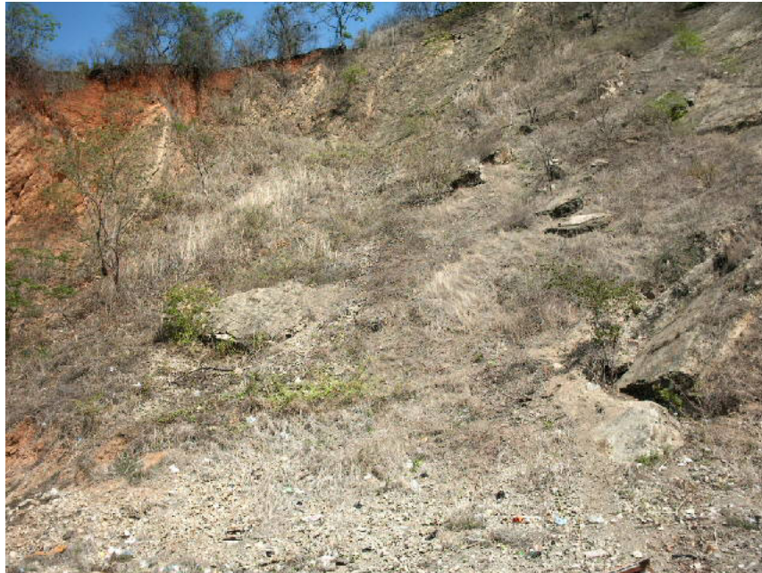
Foto 2.18 Suelos coluviales. Sector San Pedro, al Oeste de la universidad Católica.
