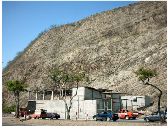
Foto 3.19 Cerro de Bellavista. pendiente muy pronunciada, además una construcción que no debería estar en este sitio por el latente peligro de desprendimiento de bloques de areniscas calcáreas con lutitas síliceas.
