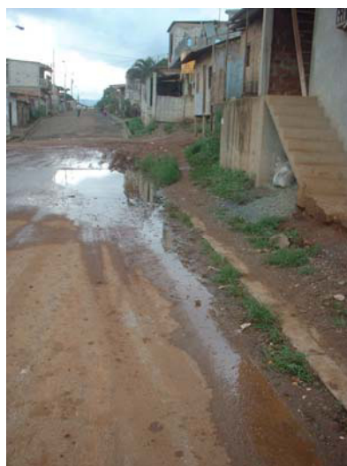
Fotos 3.7, 3.8 y 3.9 Bastión Popular, Bloque 10. El material arrastrado por el agua, pendiente abajo es evidente, toda la calle asfaltada ha sido cubierta de un material café rojizo, color característico de los suelos de la formación Cayo. Este material es parte del suelo que se ha desprendido de la colina.
