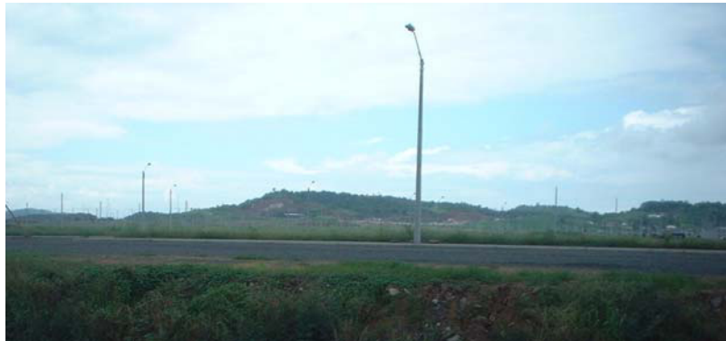
Foto 2.12 Sector Mucho Lote, suelo urbanizable, programado para la urbanización que cuenta con todos los servicios básicos.
