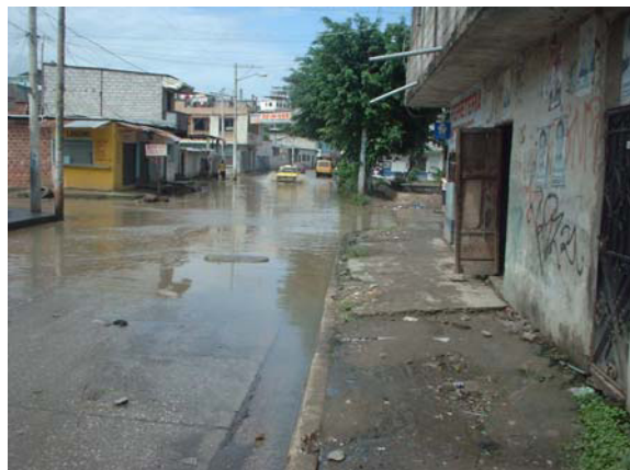
Foto 3.11 Bastión Popular, Bloque 1A. Se puede apreciar el agua lluvia acumulada en una de las vías de acceso al sector por la falta de alcantarillado pluvial.
