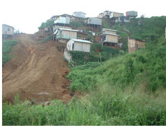
Foto 1.3 Balerio Estacio, construcciones levantadas en sectores con talud > 30%, no recomendables para ser habitadas.
