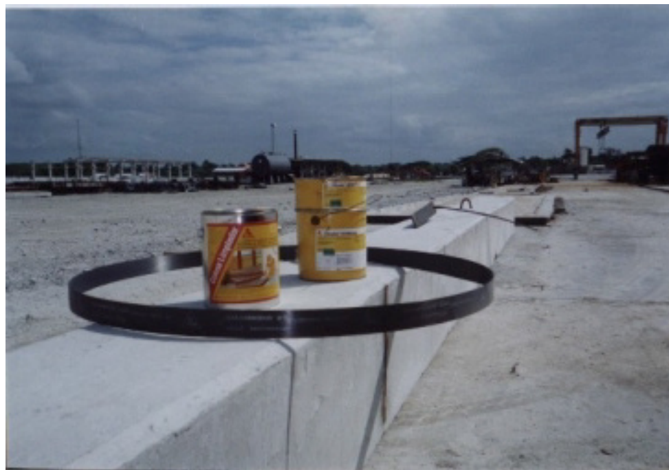
Foto 2.2. Productos Sika, Platina S512, Epóxico Sikadur 30, y Solvente.
