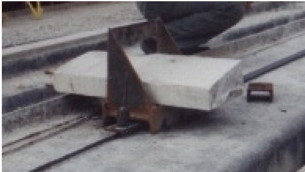
Foto 4.14. Elemento que restringe Movimiento Torsional.
