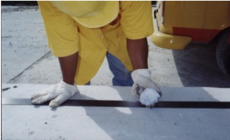
Foto 4.8. Limpieza de Platina de Carbono.
