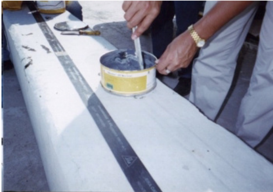
Foto No.4.9 Preparación de Epóxico.
