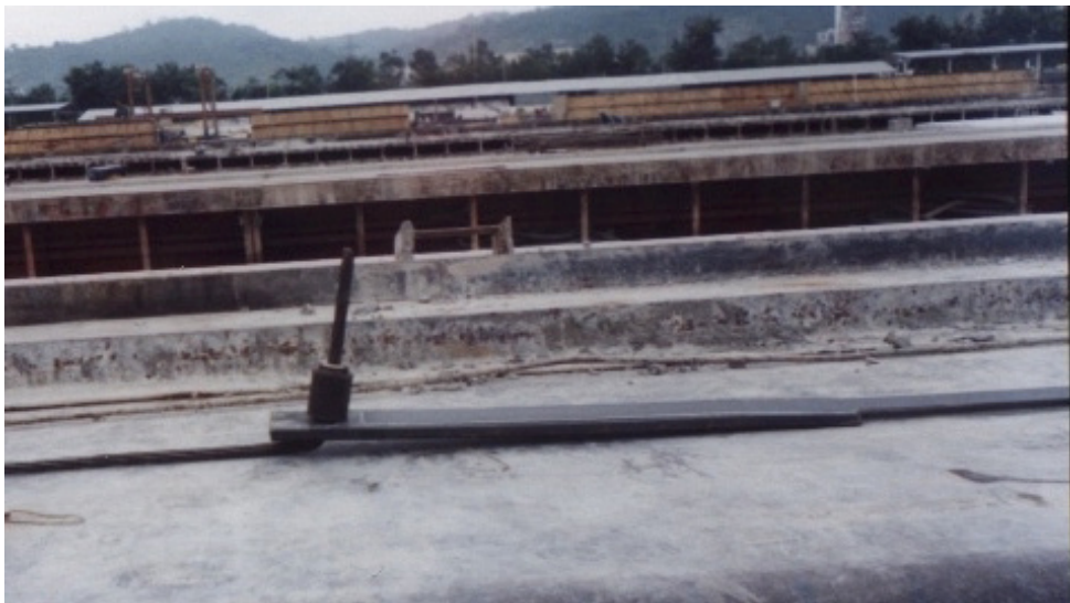
Foto 4.12. Sistema torón, Platina Metálica, Platina de Carbono.
