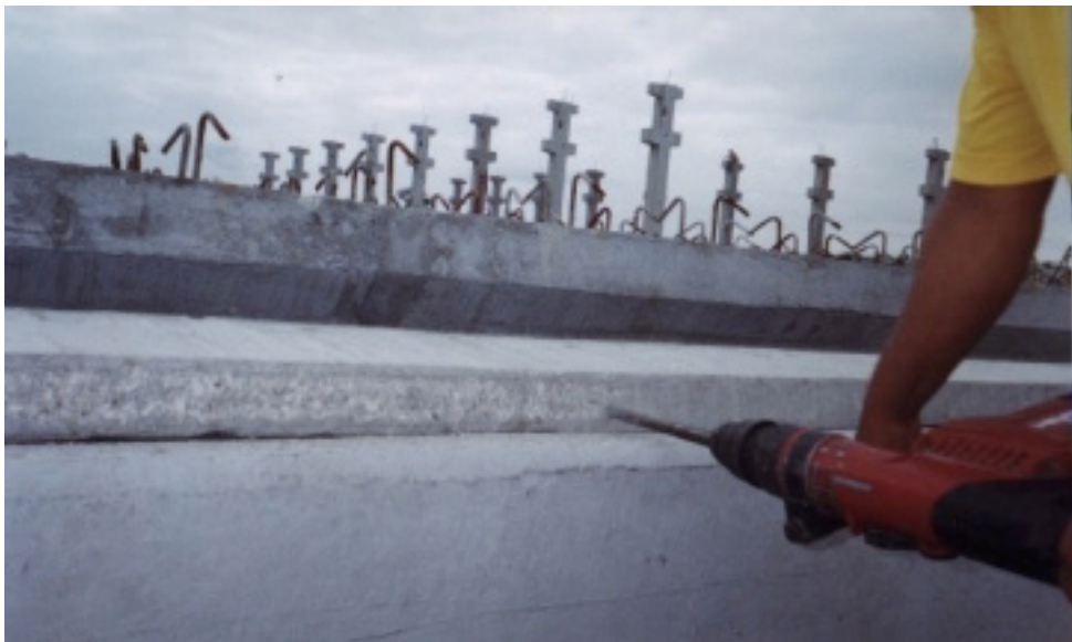
Foto 4.6 Escarificación de vigas.
