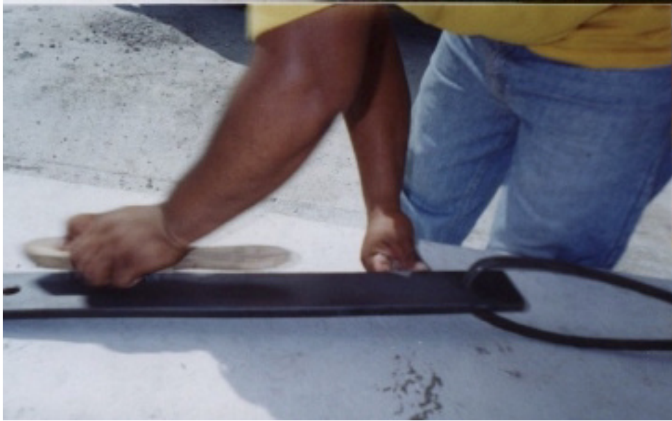
Foto 4.7. Limpieza de Platina Metálica.
