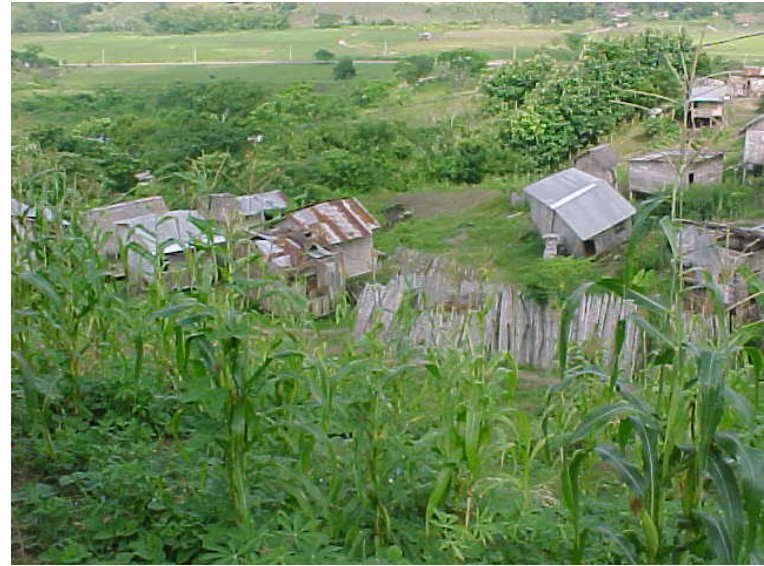
Asentamientos no controlados al pie de una ladera, interrumpiendo el drenaje natural del talud y exponiendo a la población a futuros aludes y deposición de toda clase de sedimentos
