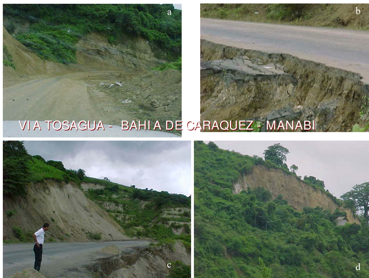
Figuras 1.4.1.2 (a, b, c, d): Deslizamiento Transnacional en la Vía Tosagua-Bahía de Caráquez
