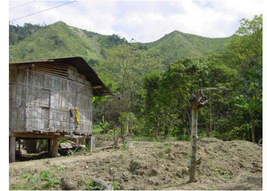
Evidencia de los procesos de deslizamiento rotacional y posteriores aludes (forma acuchillada en al parte superior de las colinas) que ha sufrido la zona, lo cual demuestra su inestabilidad y el procesos de movimiento de masas que sufre el sector
