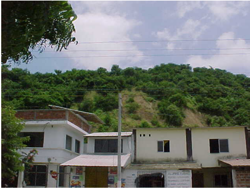
Evidencia de deslizamientos traslacionales y asentamientos de la población al pie de estos, zona de alto riesgo
