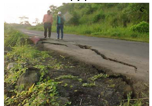
Figuras 1.4.1.1 (a,b,c): Deslizamiento Traslacionales en La Cadena-Jipijapa
