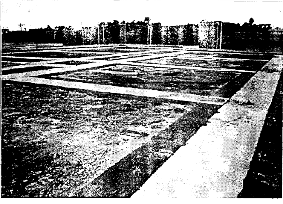
FOTO 16: Laboratorios F.I.C.T. : Petróleo: impermeabilización de cubierta colocado sólo en zona de vigas.
