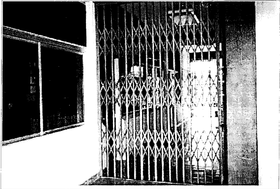
FOTO 38: Arqueología: Laboratorios: puerta metálica, puerta ventana aluminio y vidrio gris, sobrepiso de vinyl.
