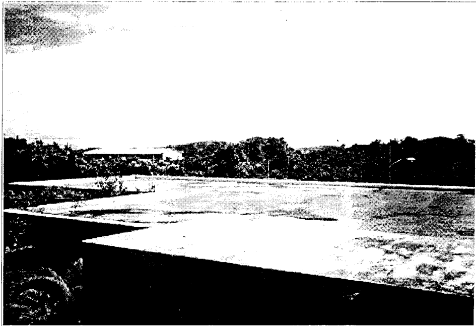
FOTO 39: Arqueología: Laboratorios: impermeabilización de cubierta, sólo en filos. Faltan pendientes hacia bajantes.
