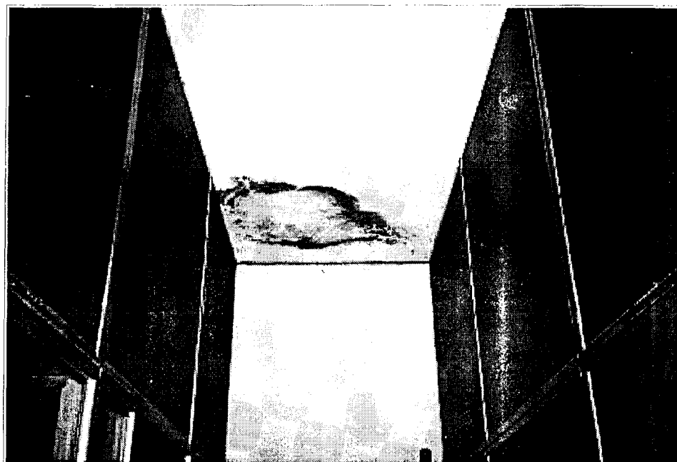
FOTO 20: Laboratorios F.I.C.T.: Suelos y Rocas: cielo raso enlucido. Pintura en mal estado por filtración en losa de cubierta.
