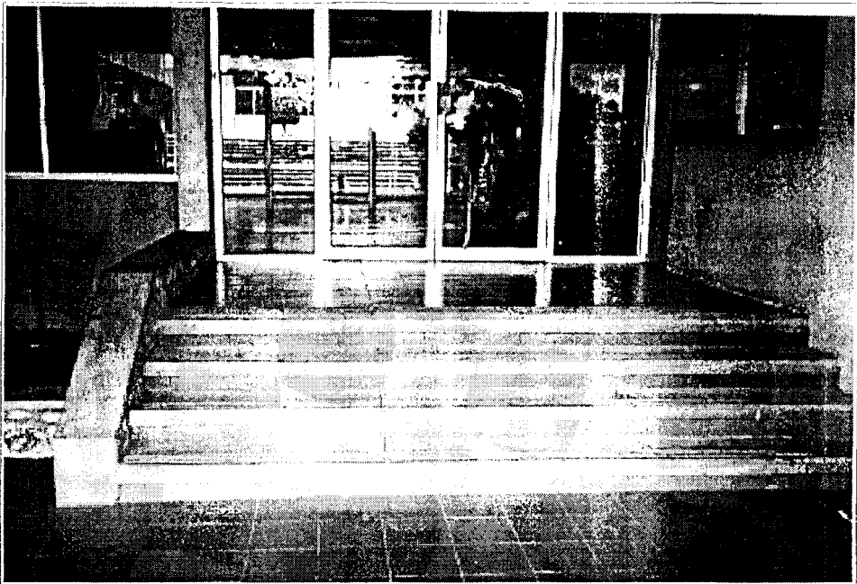
FOTO 8: Gobierno F.I.C.T.: acceso posterior, escalones prefabricados hormigón, cerámica vitrificada, muro de piedra vista, ventana de aluminio vidrio gris fija y puerta aluminio vidrio gris.
