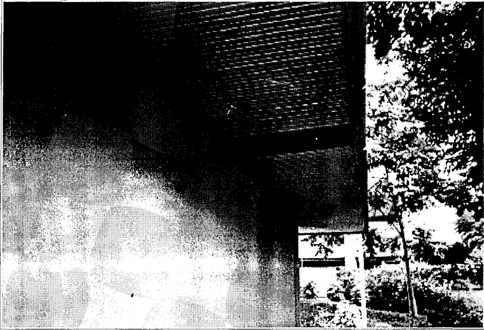
FOTO 3: Gobierno F.I.C.T.: cielo raso de aluminio en zona perimetral del edificio. Removidos los perfiles.
