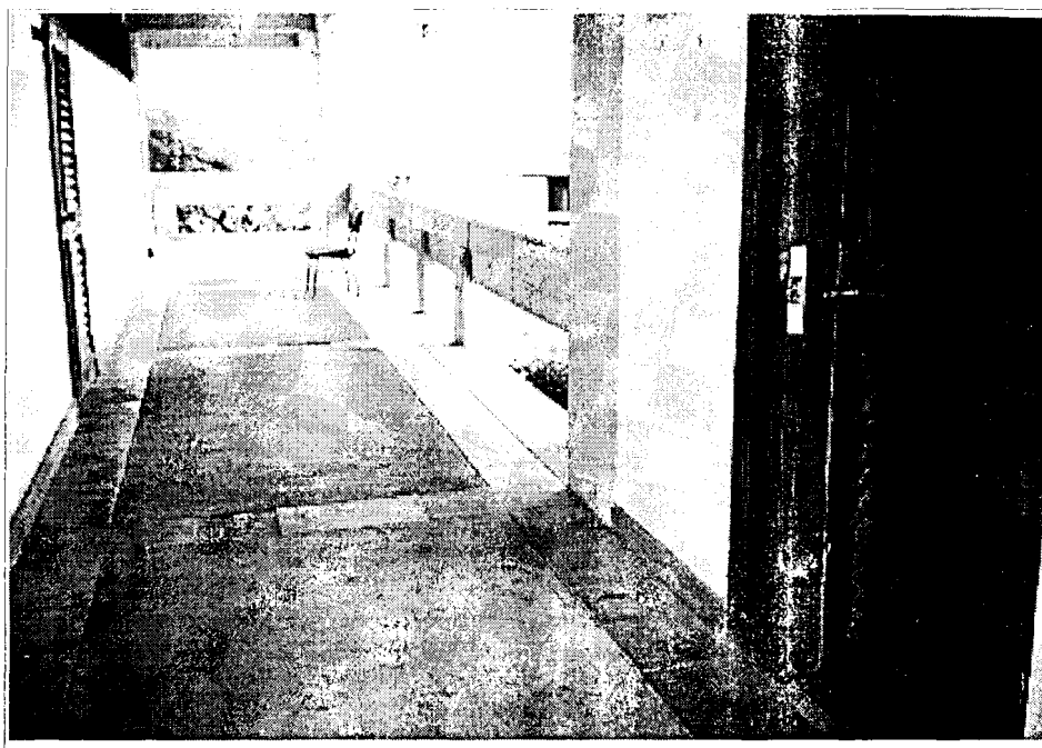
FOTO 12: Aulas F.I.C.T.: corredor planta alta. Pasamanos de hormigón visto, acabado barrido piso, recubrimiento arcilla cocida: se la ha eliminado, puerta balsamo tarjeta vidrio: ha sido cambiada de posición.
