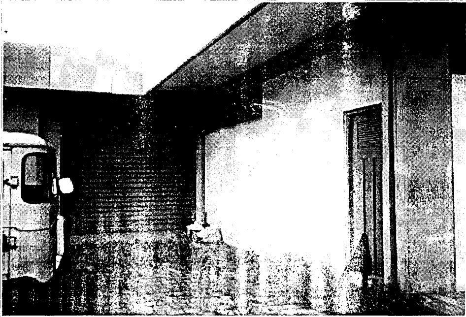
FOTO 22: Laboratorios F.I.C.T.: Suelos y Rocas: puerta metálica enrollable, puerta metálica, bajante AA.L.L., ventana de aluminio vidrio gris celosías.
