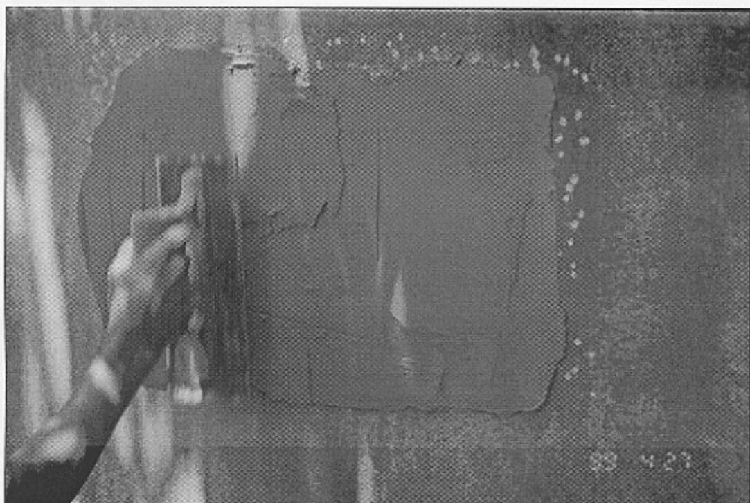
**FOTO #7.- Muestra de enlucido de un Mortero con pigmento.**
