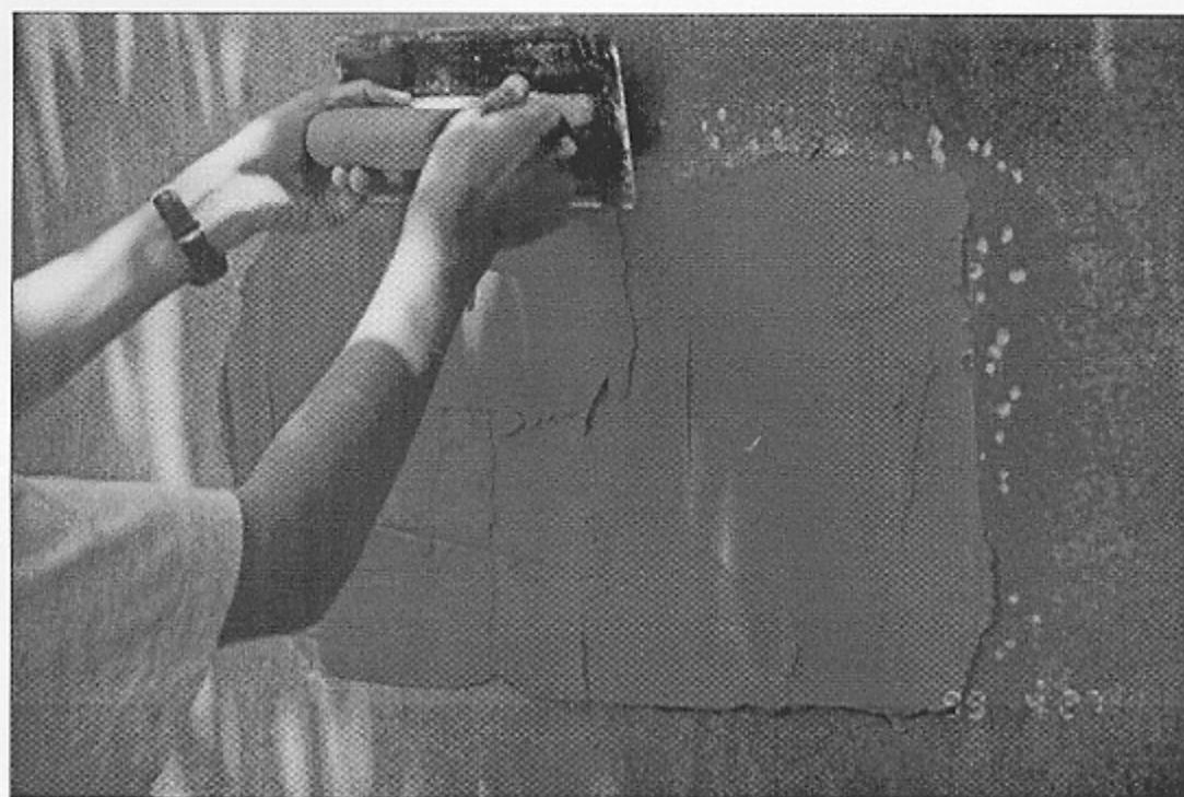
**FOTO #8.- Muestra de enlucido de un Mortero con Pigmento.**
