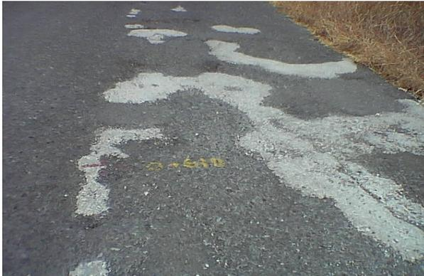
**Foto 1.3.7. Baches rellenos de hormigón hidráulico**
