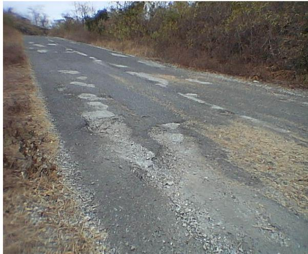
**Foto 2.3.6.13. Baches rellenos con hormigón simple**
