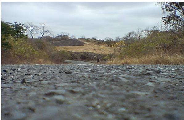
**Foto 1.3.6. Agregados expuestos en superficie de rodadura**
