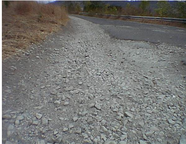
**Foto 2.3.6.3. Reducción del ancho de la calzada**
