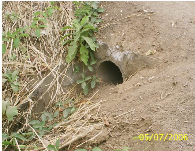
**Foto 2.3.9.2. Alcantarilla sección circular existente en la vía**
