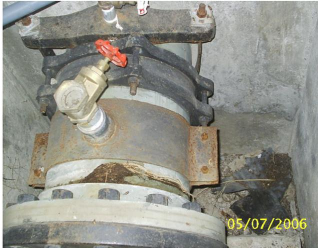
**Foto 3.1.1.3. Válvula de compuerta existente**
