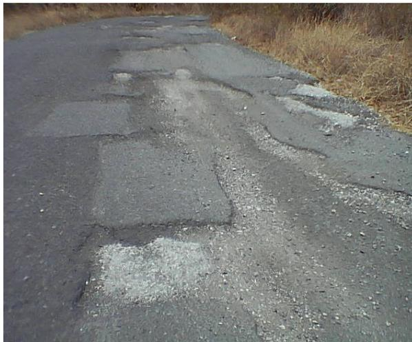
**Foto 2.3.6.1. Estado actual de la superficie de rodadura del pavimento flexible**
