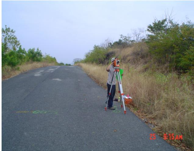
**Foto 2.4.1.1. Levantamiento Topográfico con teodolito**
