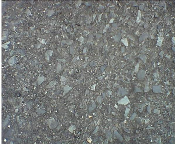
**Foto 2.3.6.6. Desgaste de los áridos debido al efecto de abrasión por el tránsito**
