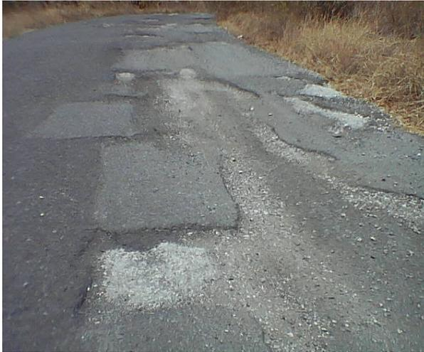
**Foto 2.3.6.12. Capa de rodadura desprendida del firme**
