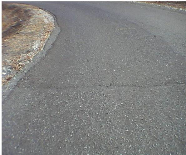
**Foto 2.3.6.5. Línea de rotura transversal al eje de la carretera**
