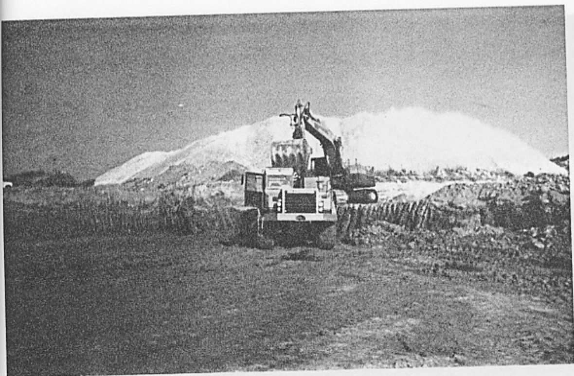
FOTOGRAFÍA A5. EXCAVACIÓN
