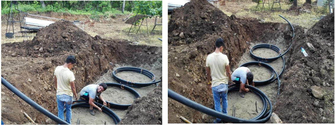
Figura 18. Instalación de tubería.
