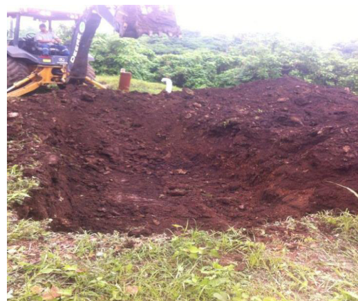
Figura 15. Excavaciones de zanja.
