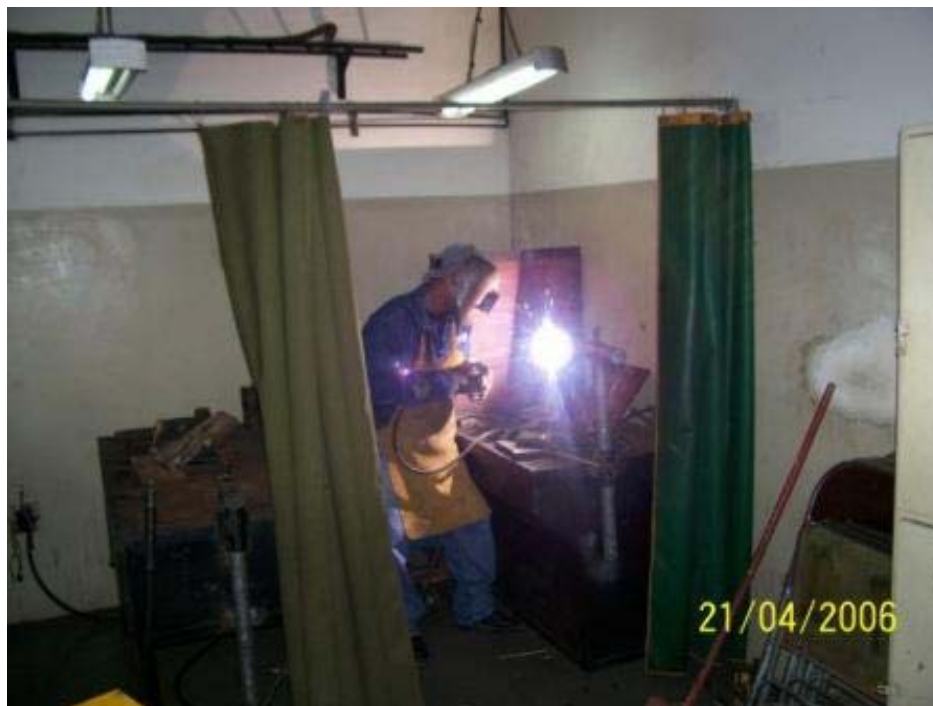
FIGURA. 3.4 FOTOGRAFÍA DEL OPERADOR SOLDANDO EN POSICIÓN 3G.
