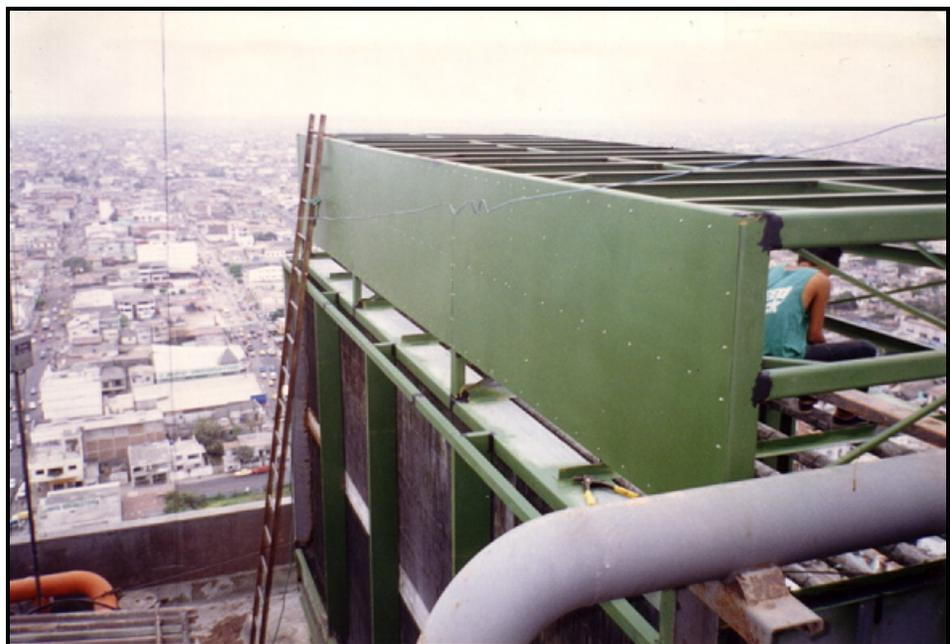
**Figura 2.4.** INSTALACIÓN ESTRUCTURA BASE PARA VENTILADORES
