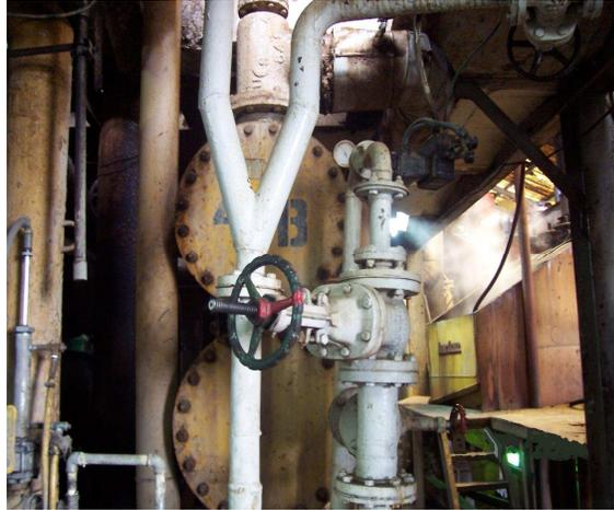
**Figura 1.8 Tubería para la dosificación de lechada de cal**
