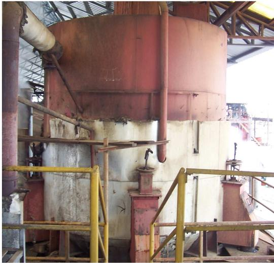
**Figura 1.14. Tanque para la floculación**
