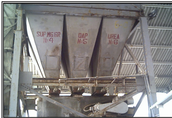
TOLVAS DE ALMACENAMIENTO
