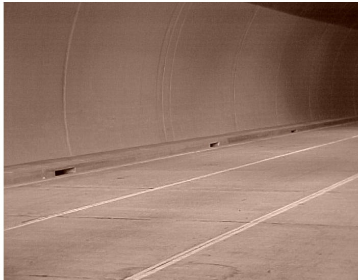
Figura 4. 2 Acera, Sumidero y Revestimiento en Túnel 2
