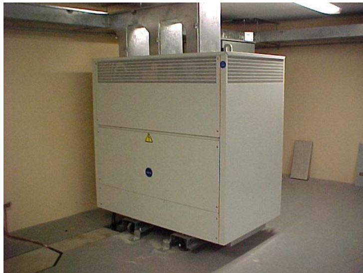
Figura 4. 8 Tranformador
