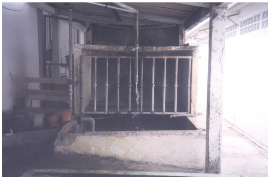
Figura 1.4 Cisterna de Enfriamiento
