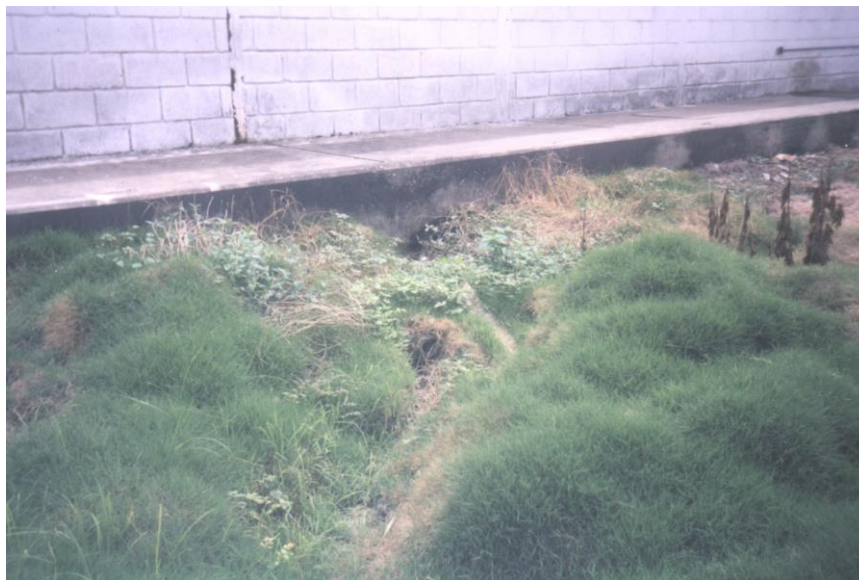
Figura 2.5 Desfogue de agua al exterior de la planta
