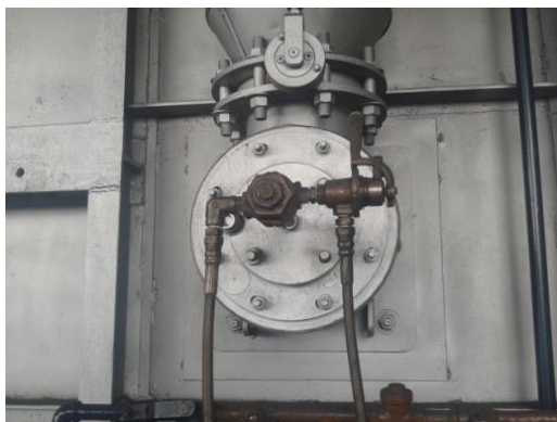
FIGURA 1.5 QUEMADOR DEL HORNO
