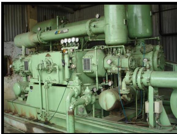
**FIGURA 2.7. COMPRESOR DE CUATRO ETAPAS PARA AIRE COMPRIMIDO DE ALTA PRESIÓN**
