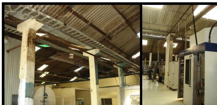
**FIGURA 2.10. TUBERÍA DE AIRE COMPRIMIDO DE ALTA PRESIÓN**
