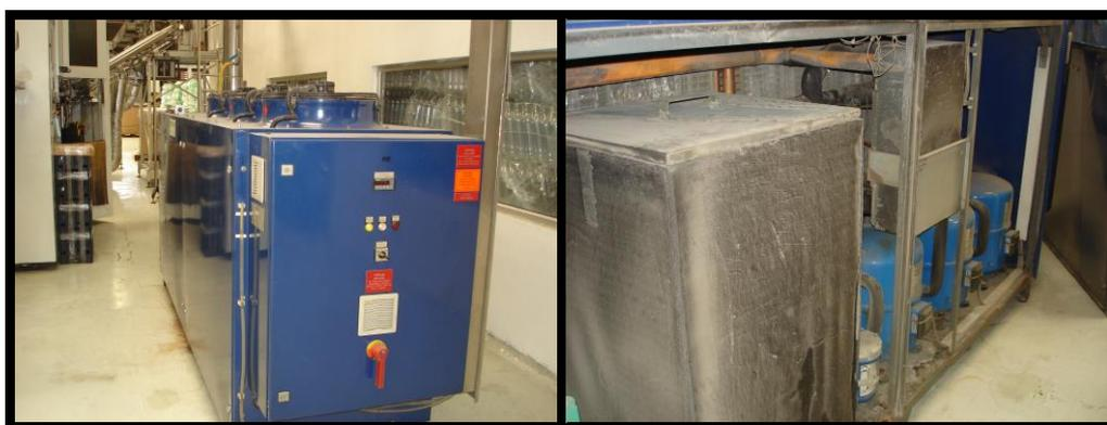
**FIGURA 2.17. CHILLER KLC 63 - SISTEMA DE ENFRIAMIENTO**
