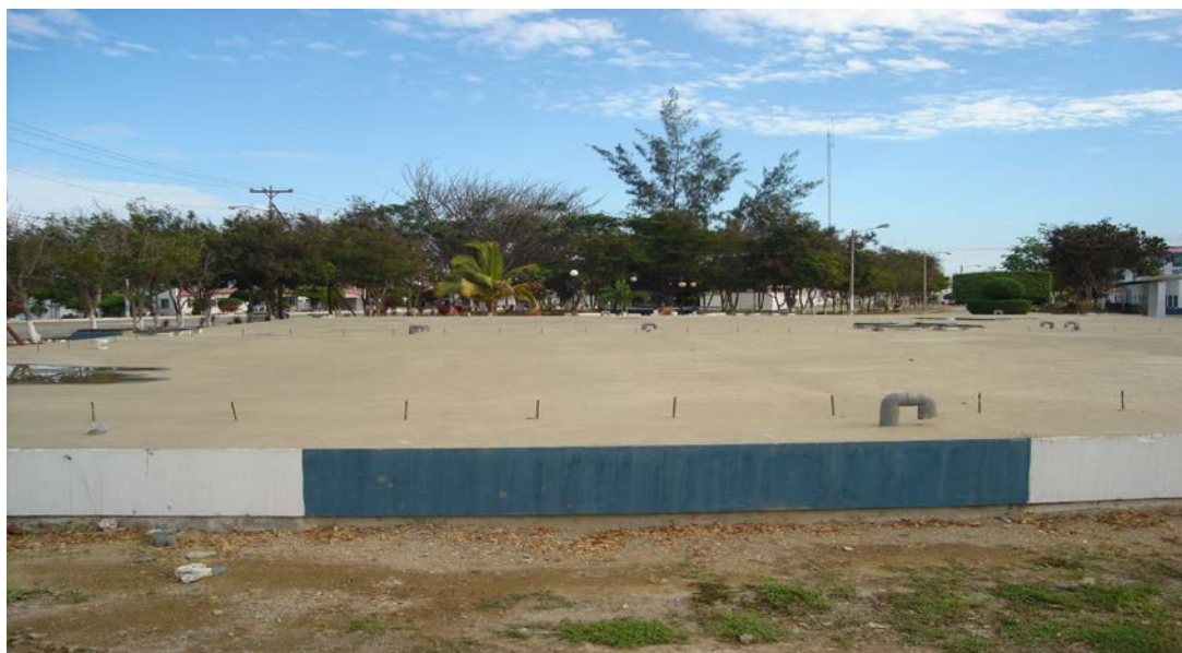
FIGURA 4.1 CISTERNA DE ALMACENAMIENTO
