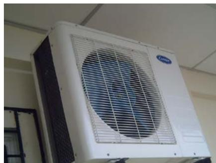
FIGURA 1.6. UNIDAD EVAPORADORA (IZQ.) – UNIDAD CONDENSADORA (DER.) MARCA CARRIER DE 24,000 BTU
