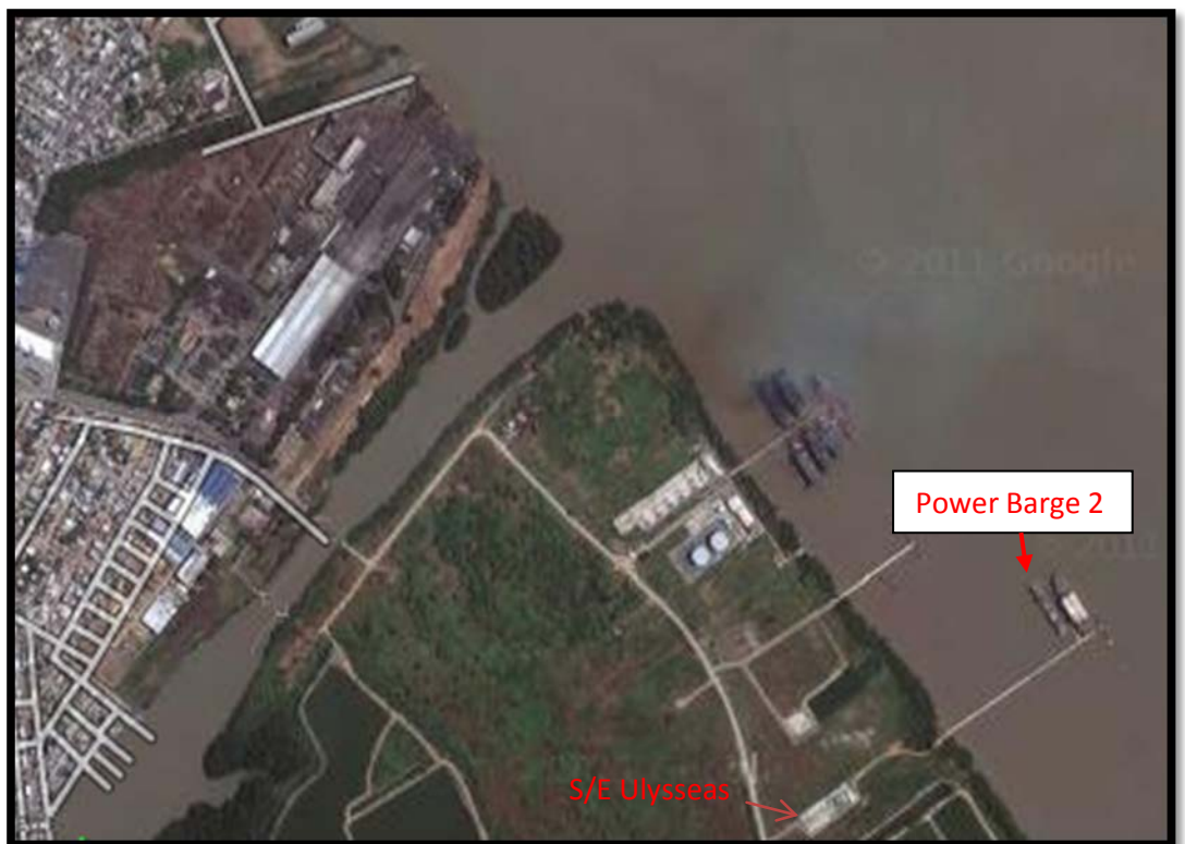
Fig. b: Acercamiento de la situación geográfica de Power Barge 2
