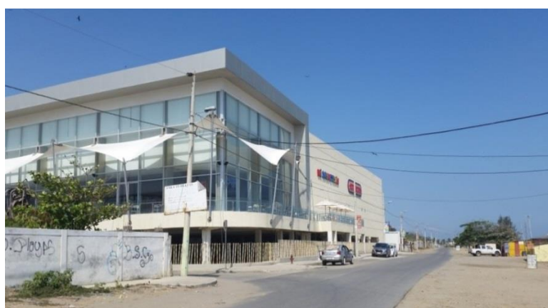
Figura 3.40 Lugar de Instalación de la Tercera Sirena electrónica
