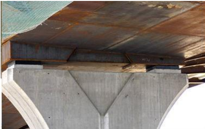
Ilustración 3.2: Vigas de paso desnivel
