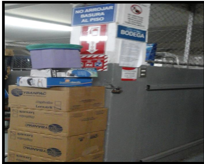
Figura 2.14: Falta extintor
