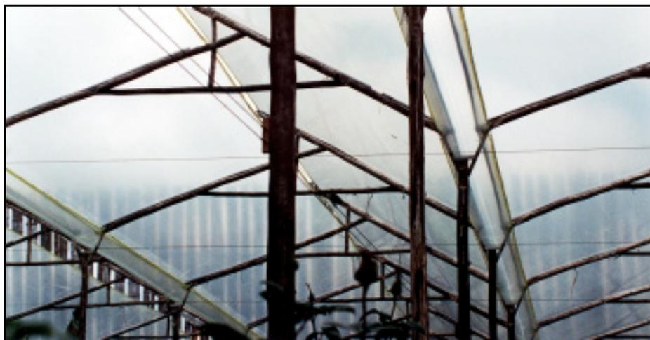
FOTO 8: CUBIERTA DE INVERNADERO CON ESTRUCTURA DE MADERA
