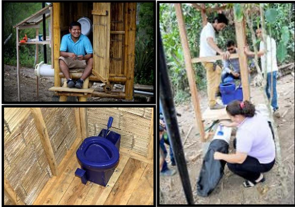
**Figura 2.24: Baño Ecológico instalado.**
