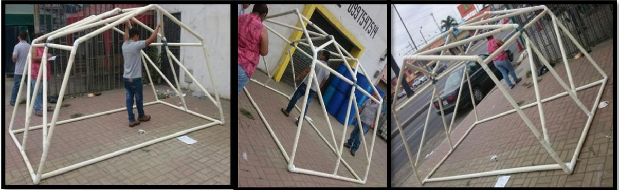
Figura 2.2: Refugio hecho de PVC ensamblado.
