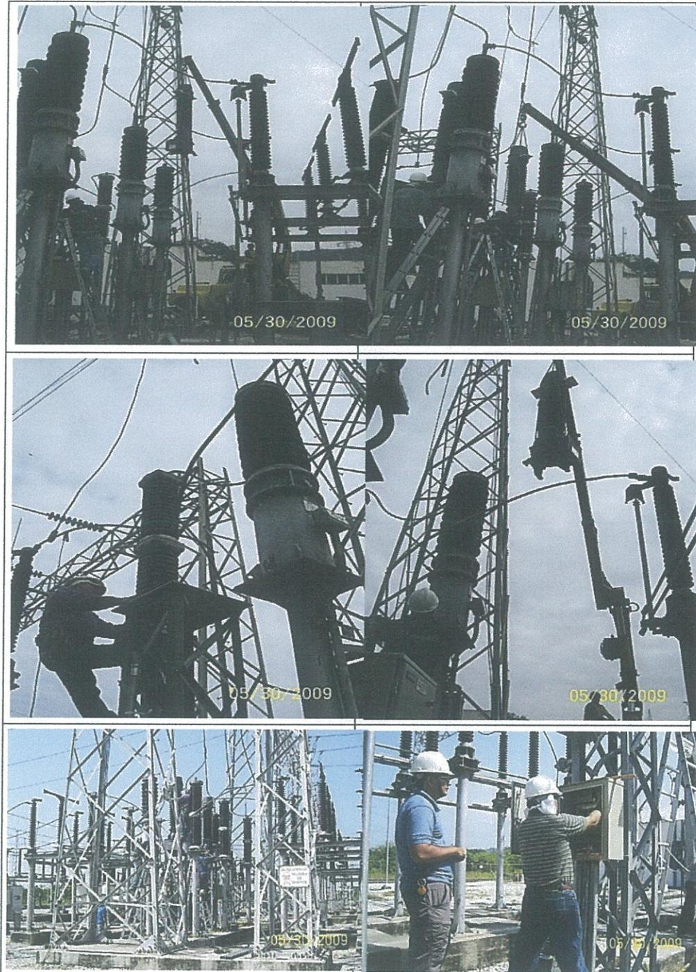
FIGURA 5.4 MONTAJE Y PRUEBAS DE TRANSFORMADORES DE CORRIENTE
