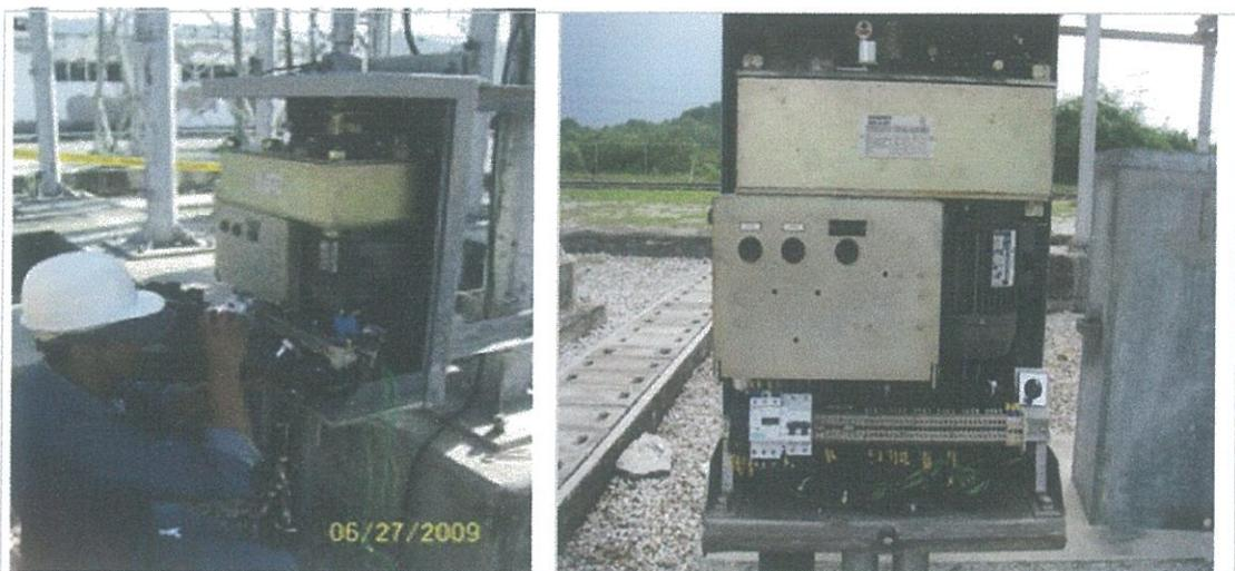
FIGURA 4.6 MODIFICACIONES EN SECCIONADORES MAGRINI GALILEO
