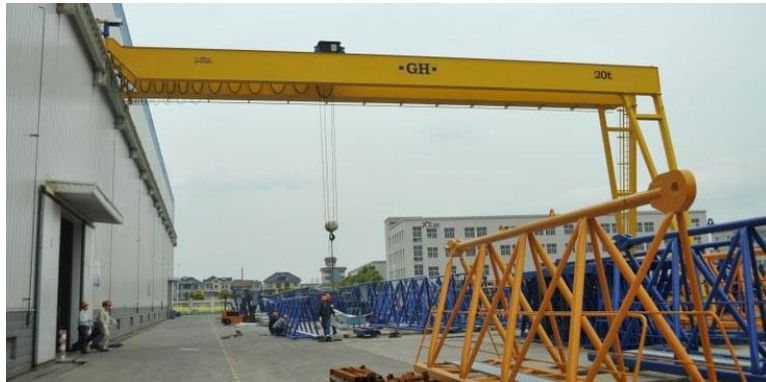
Figura 1.4 Puente Grúa Semipórtico
