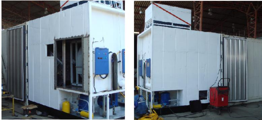
Figura 4.1 Construcción de prototipo
