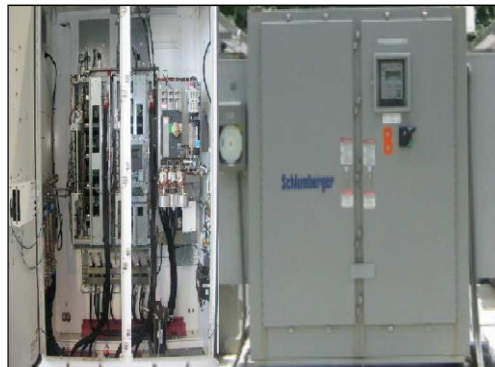
Figura 12. Controlador de Variación de Velocidad. Fuente: “REDA”, Schlumberger (Schlumberger, 2016).
